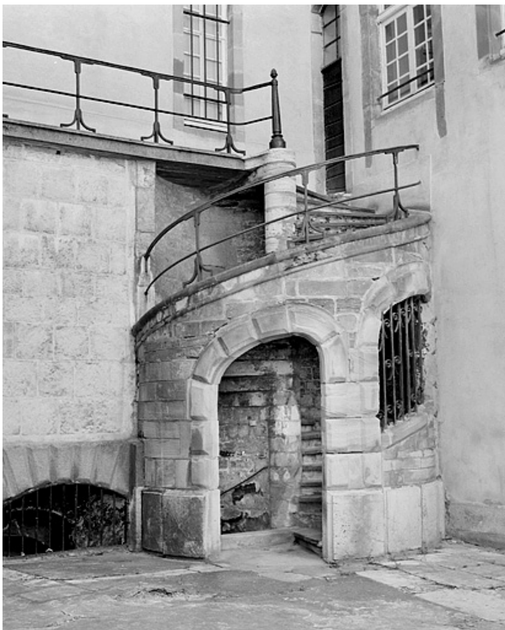
Cour de l'Ours. Escalier de la coursière.
