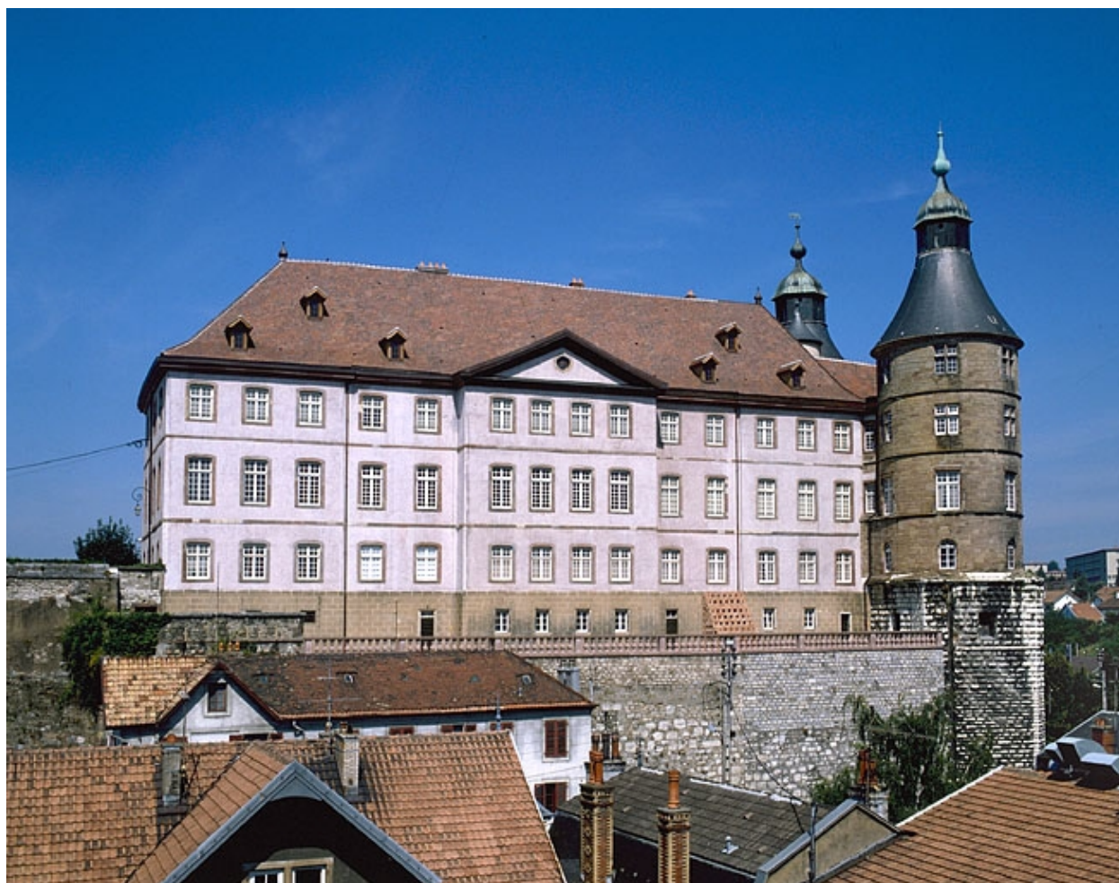
Corps de bâtiment principal. Côté sud.
