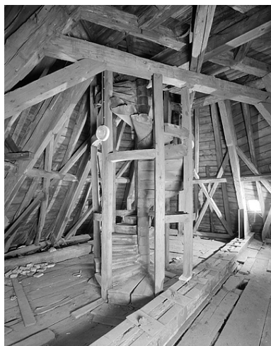
Tour Henriette. Charpente et escalier conduisant au lanteron. Phot. Jérôme Mongreville IVR43_19872501229V
