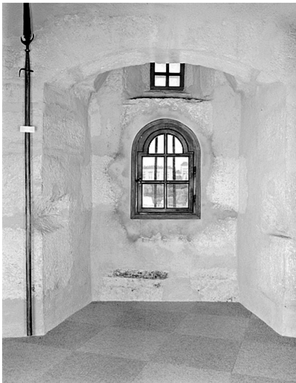
Tour Henriette. Fenêtre du troisième niveau.
