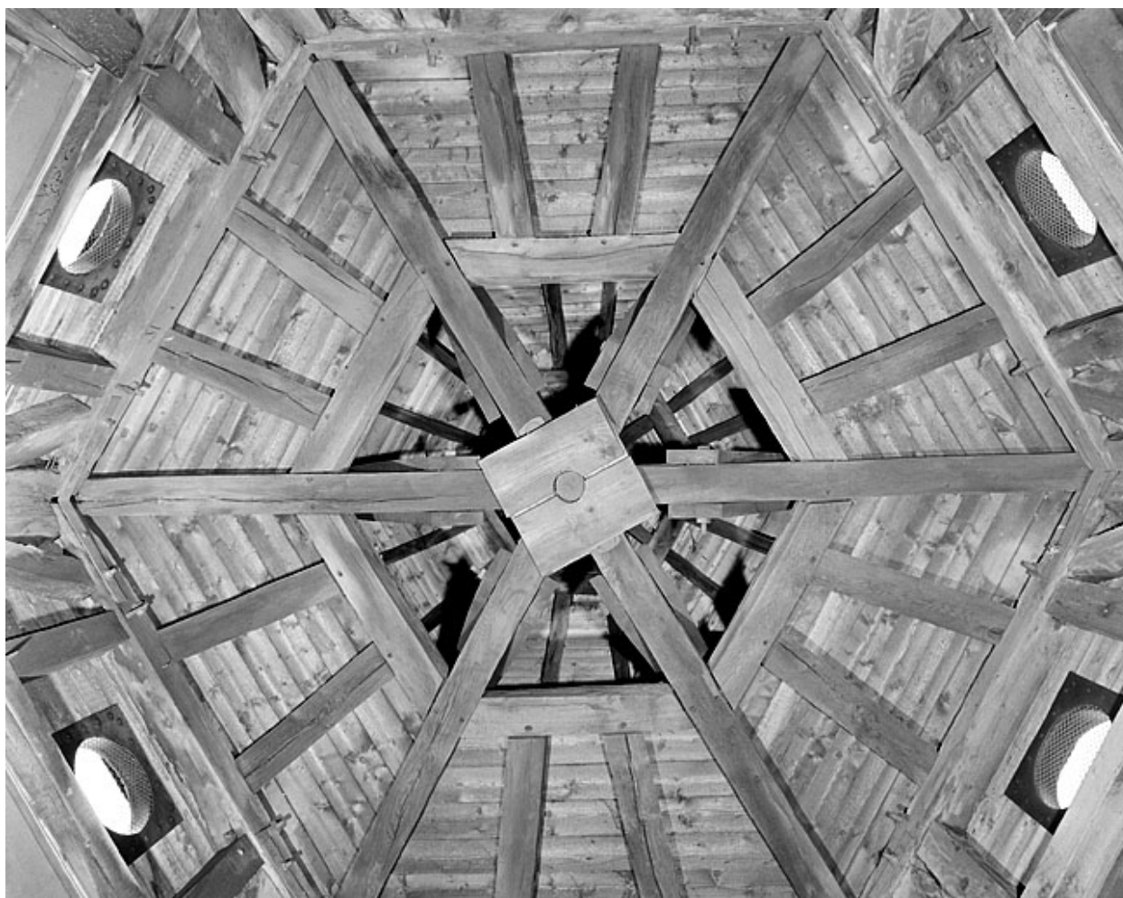
Tour Henriette. Charpente du lanternon.
