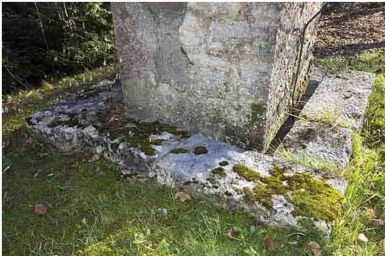
Mire sud de la lunette méridienne, pilier sud : fossé de stabilisation à la base du pilier.
