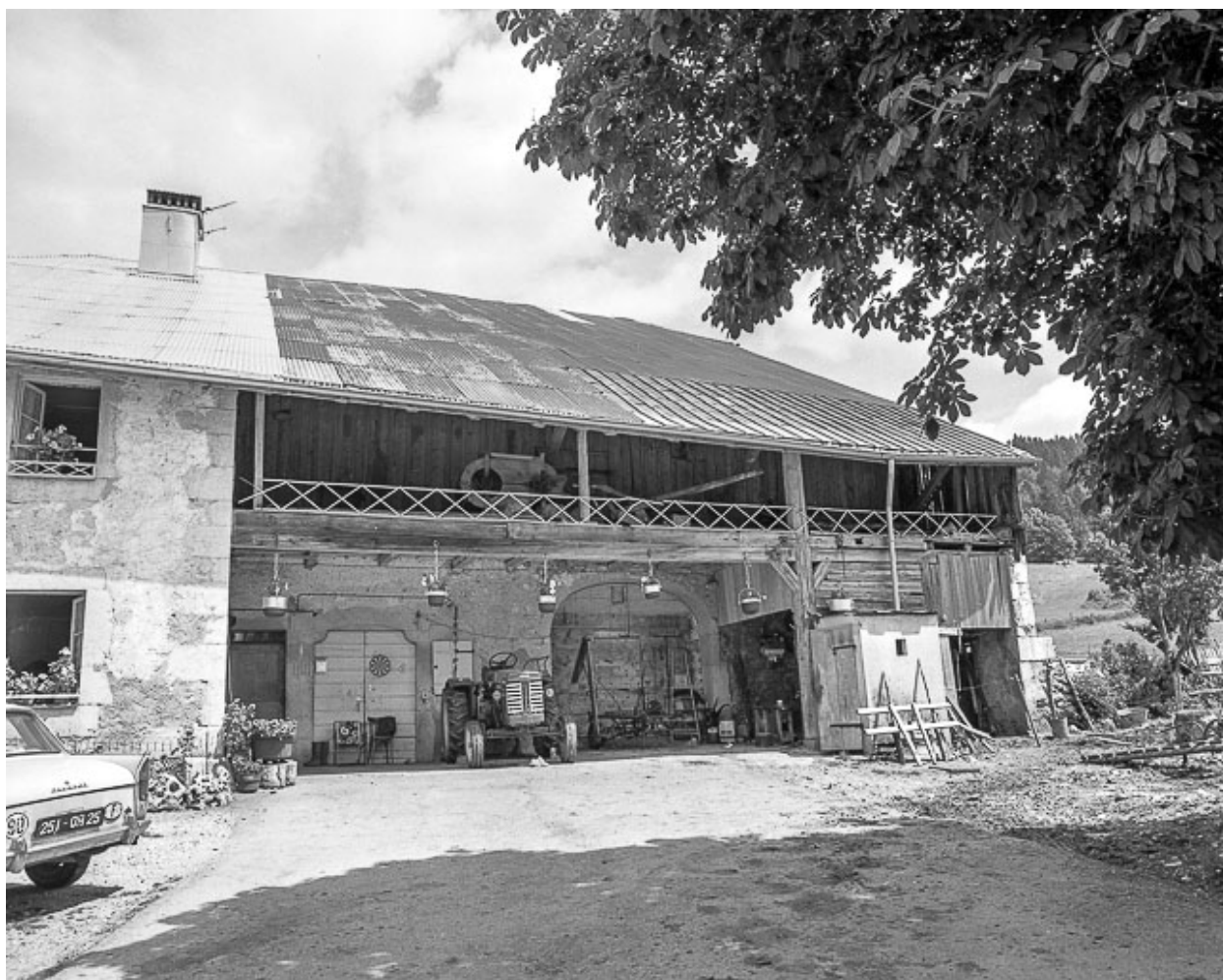
Façade latérale droite.
