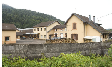
Bureaux et conciergerie depuis la rive droite.
