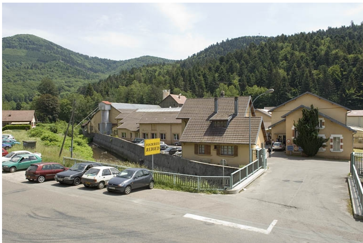
Partie nord de l'usine depuis l'entrée.
