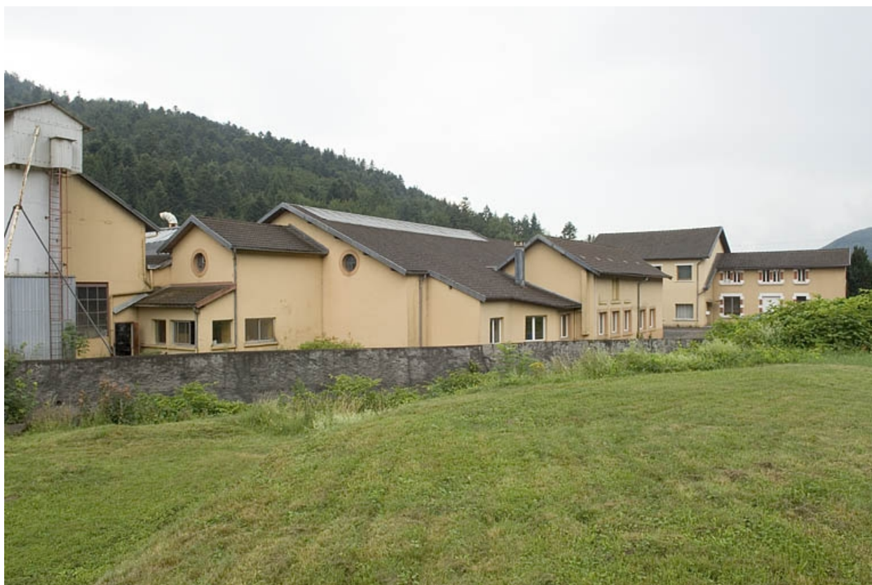
Ateliers de fabrication depuis le nord.
