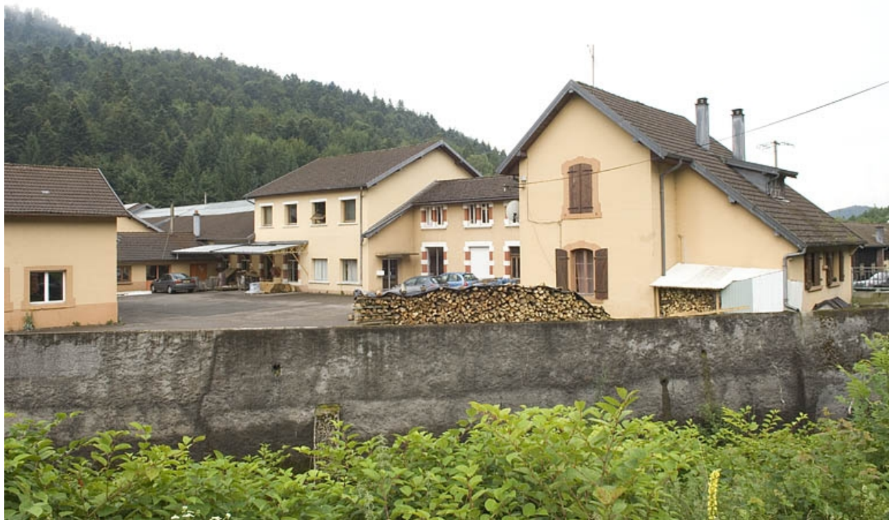
Bureaux et conciergerie depuis la rive droite.
