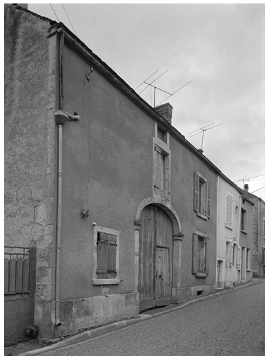
Façade sur rue. Phot. Jean-Luc Duthu IVR26_19748901249V
