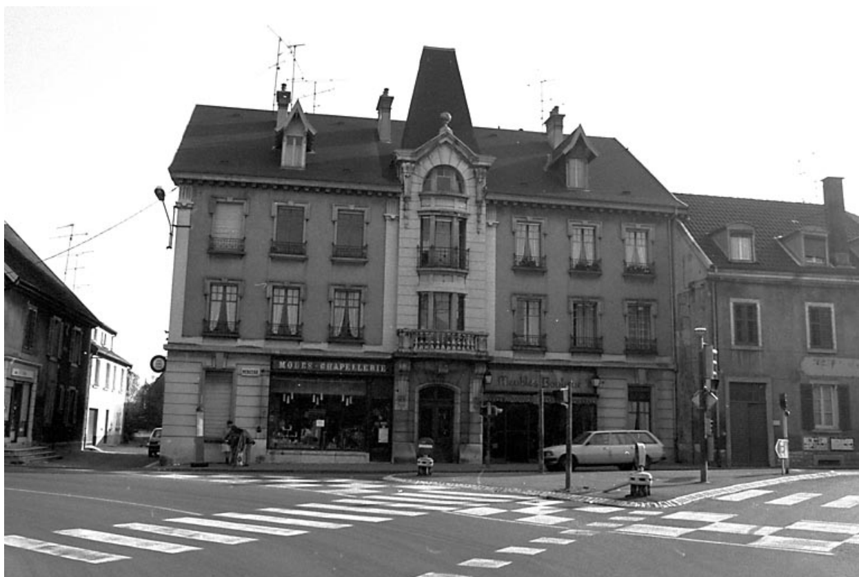
Immeuble situé 69 rue de Belfort.
