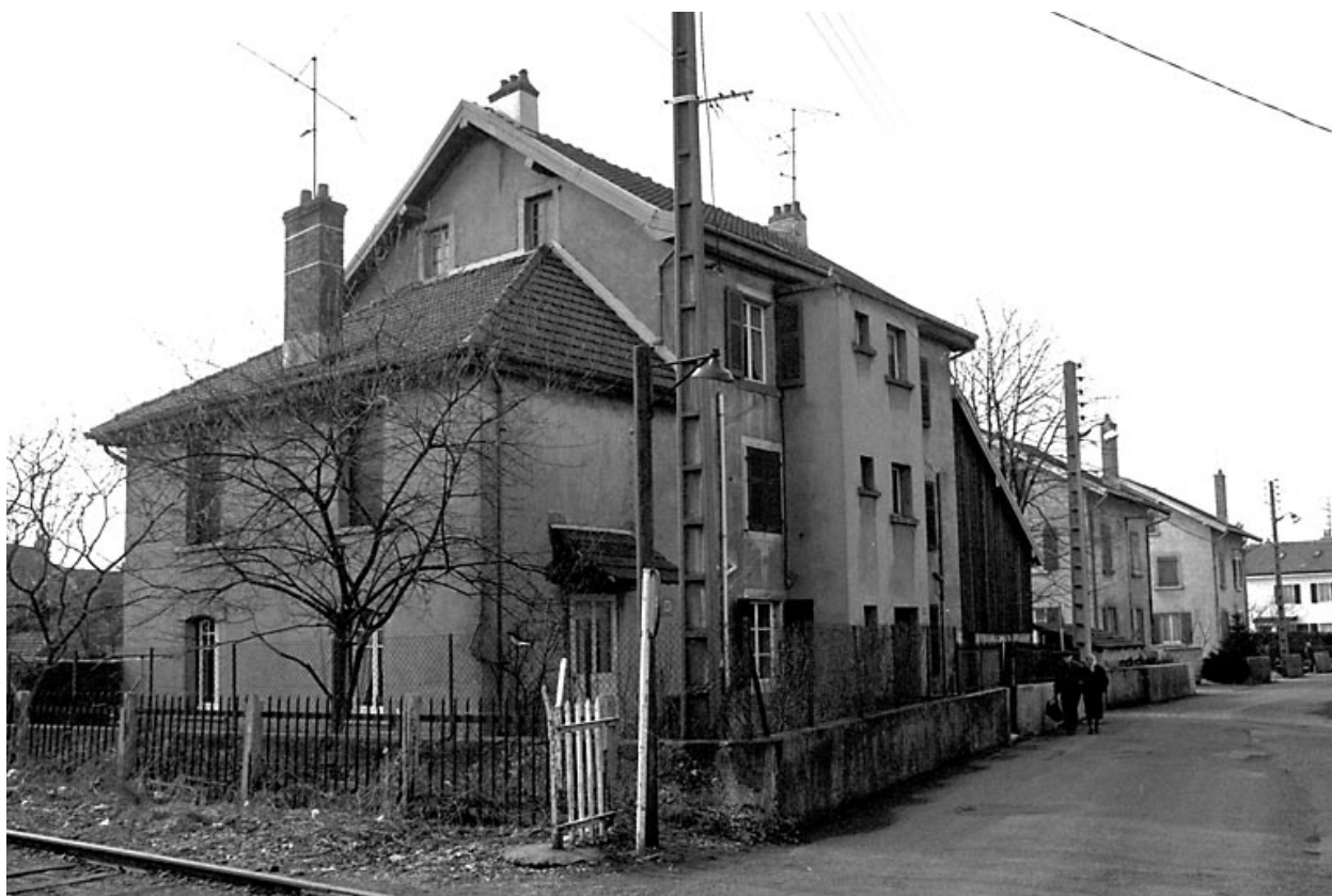
Immeuble situé 43 rue de Champagne.
