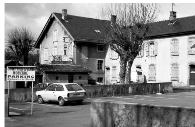
Immeuble situé 2 rue de Valentigney. Phot. Bernard Lardière IVR43_19832500264Z
