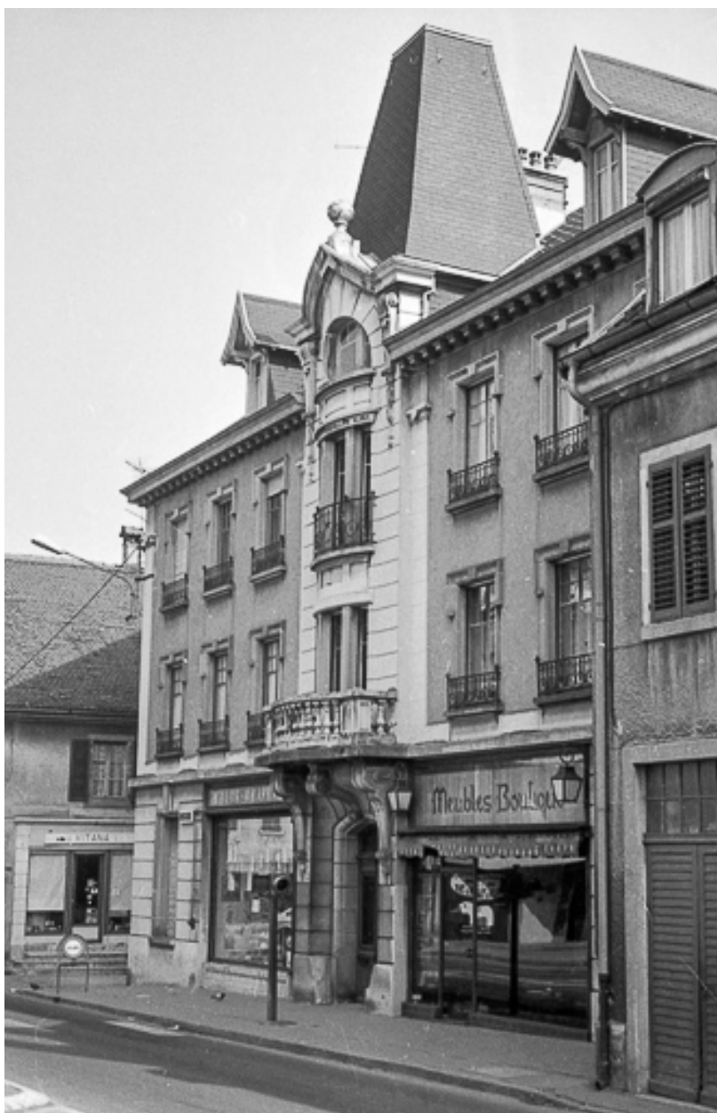
Immeuble situé 69 rue de Belfort.
