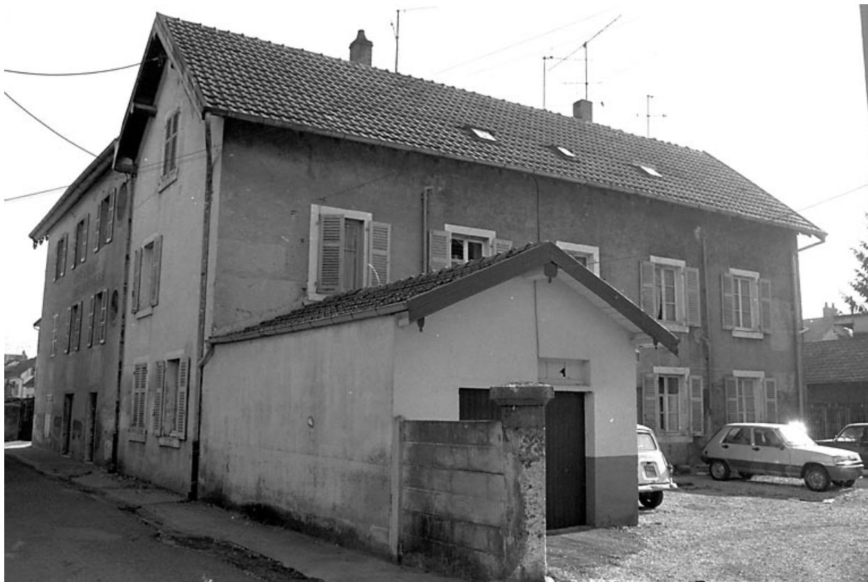
Immeuble situé 19 rue Neuve.
