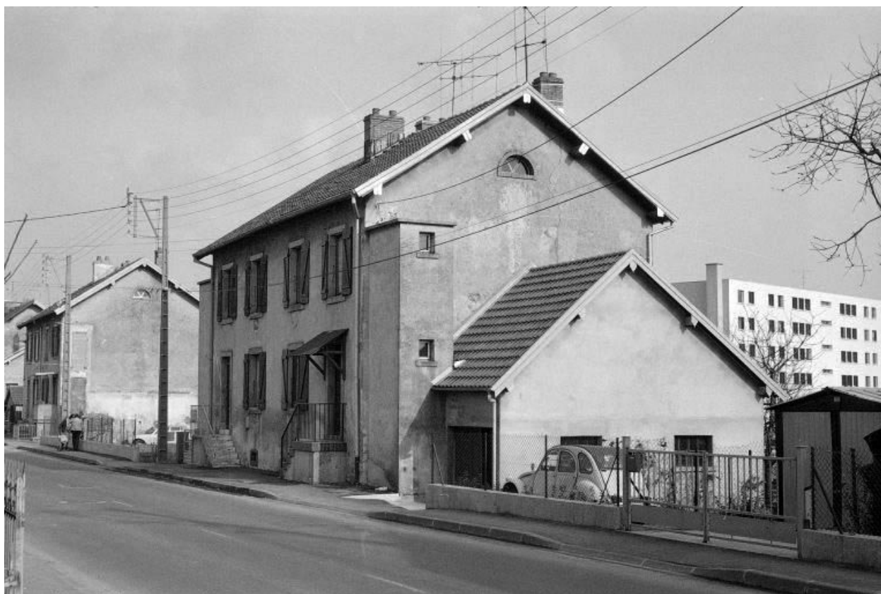
Immeuble situé 33-35 rue des Mines.
