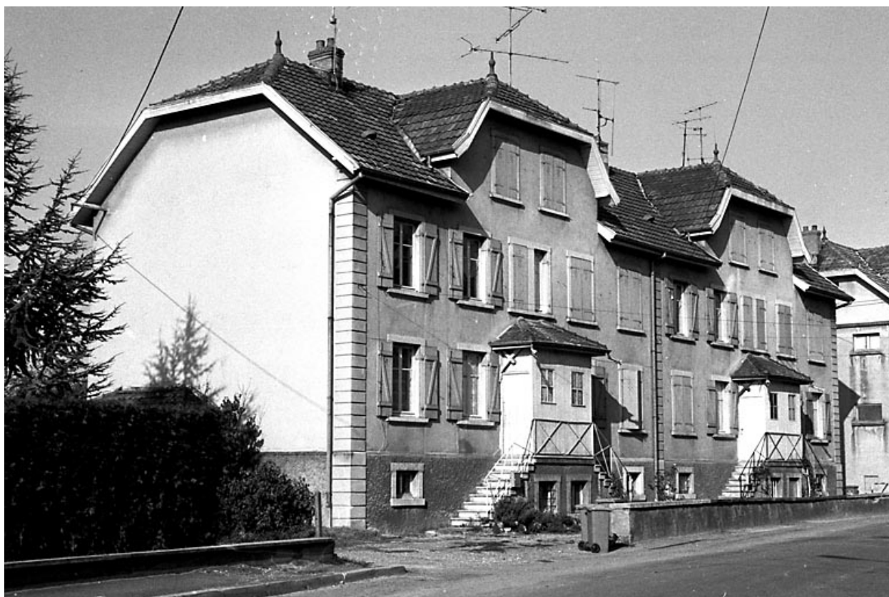
Immeuble situé 3 avenue de la Gare.
