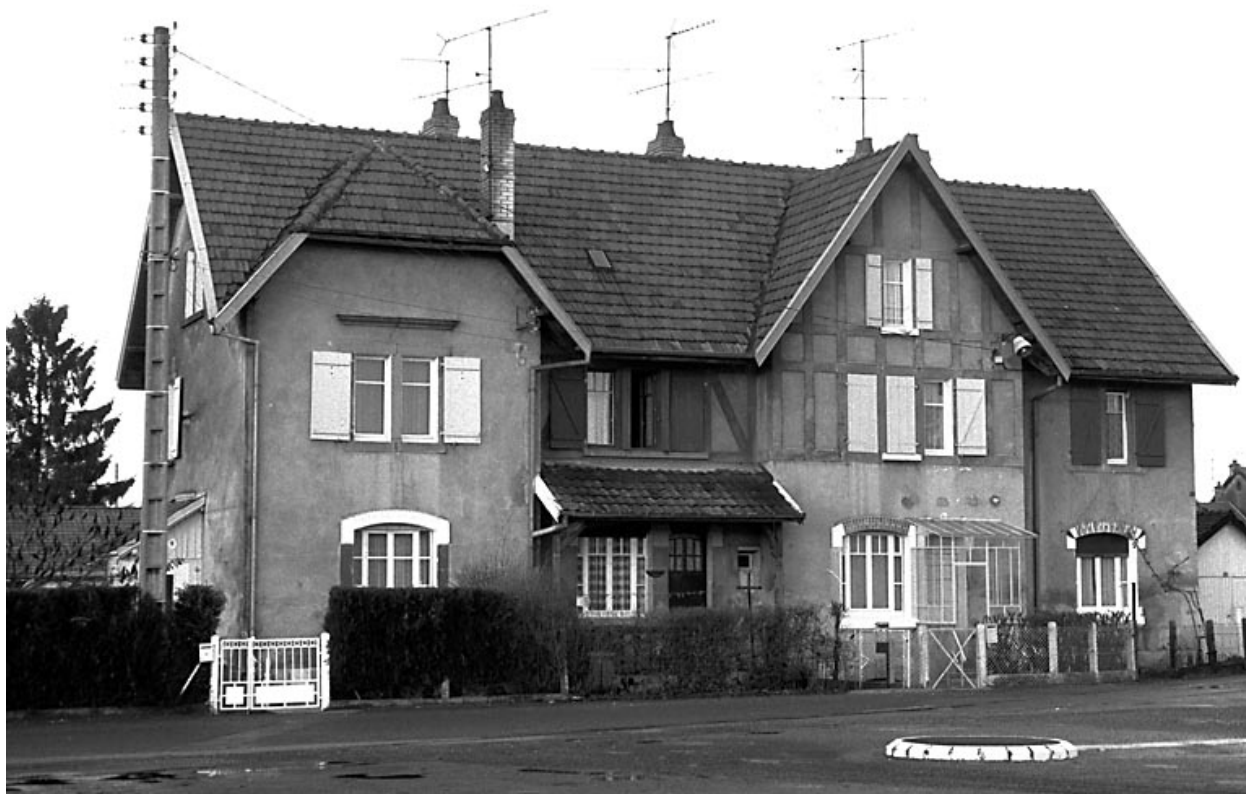
Immeuble situé 15 rue de Verdun.
