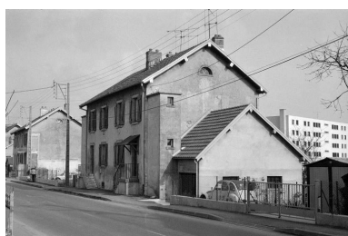
Immeuble situé 33-35 rue des Mines. Phot. Bernard Lardière IVR43_19832500266Z
