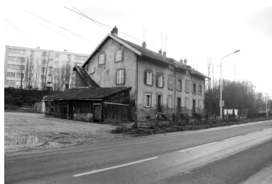
Immeuble situé 61 rue de Valentigney. Phot. Bernard Lardière IVR43_19832500269Z
