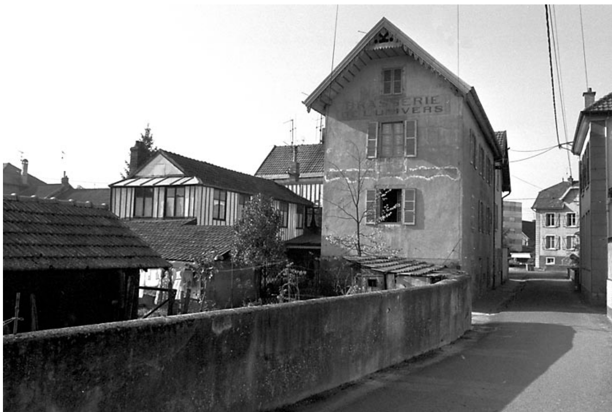
Immeuble situé 17 rue Neuve.
