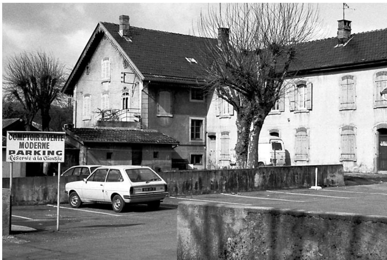
Immeuble situé 2 rue de Valentigney.
