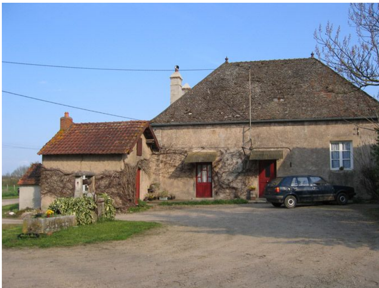
Vue d'ensemble de la façade de l'habitation.
