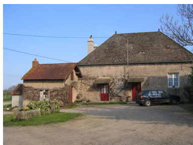
Vue d'ensemble de la façade de l'habitation.
