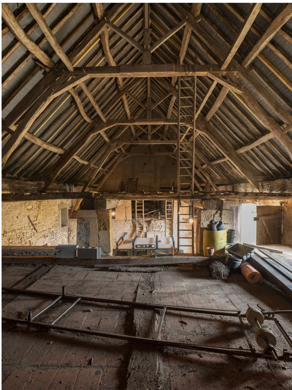
Charpente de la grange, construite en 1831.
