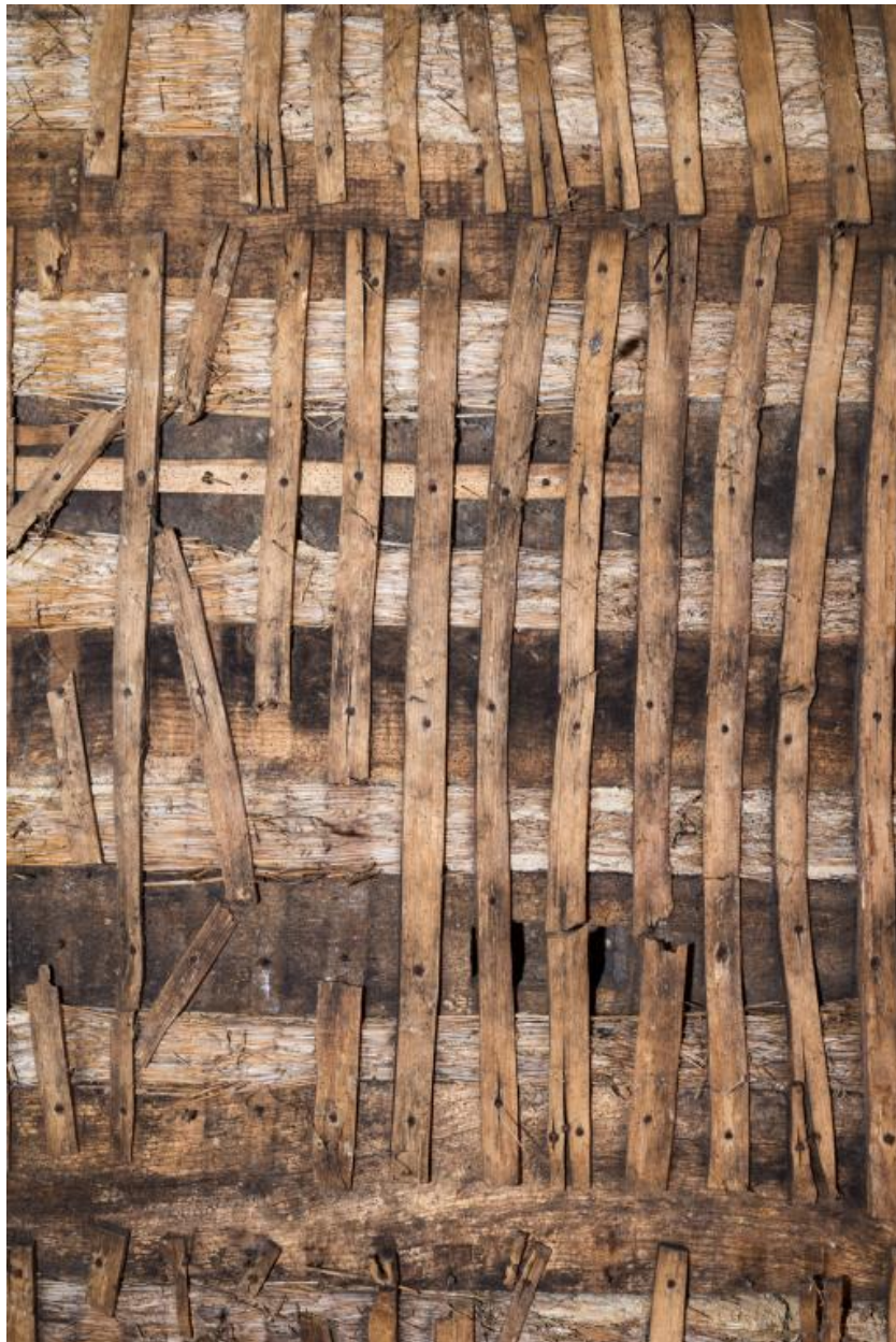
Détail d'un plancher dans la dépendance, constitué de pièces de bois (solives), de bottes de paille et couvert d'un lattes
