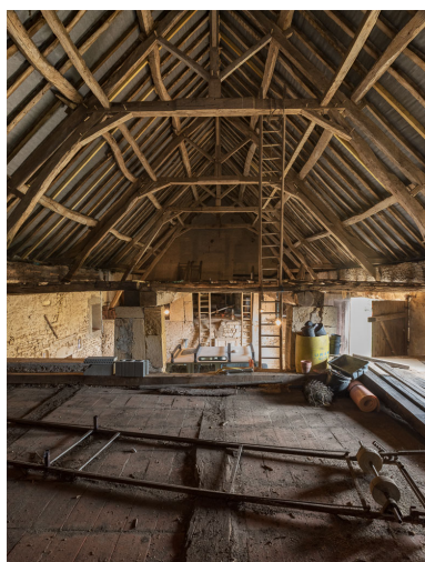
Charpente de la grange, construite en 1831.
