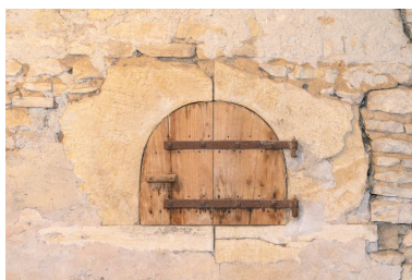
Vue d'un feuron depuis la remise Phot. Pierre-Marie Barbe-Richaud IVR26_20187100275NUC4A
