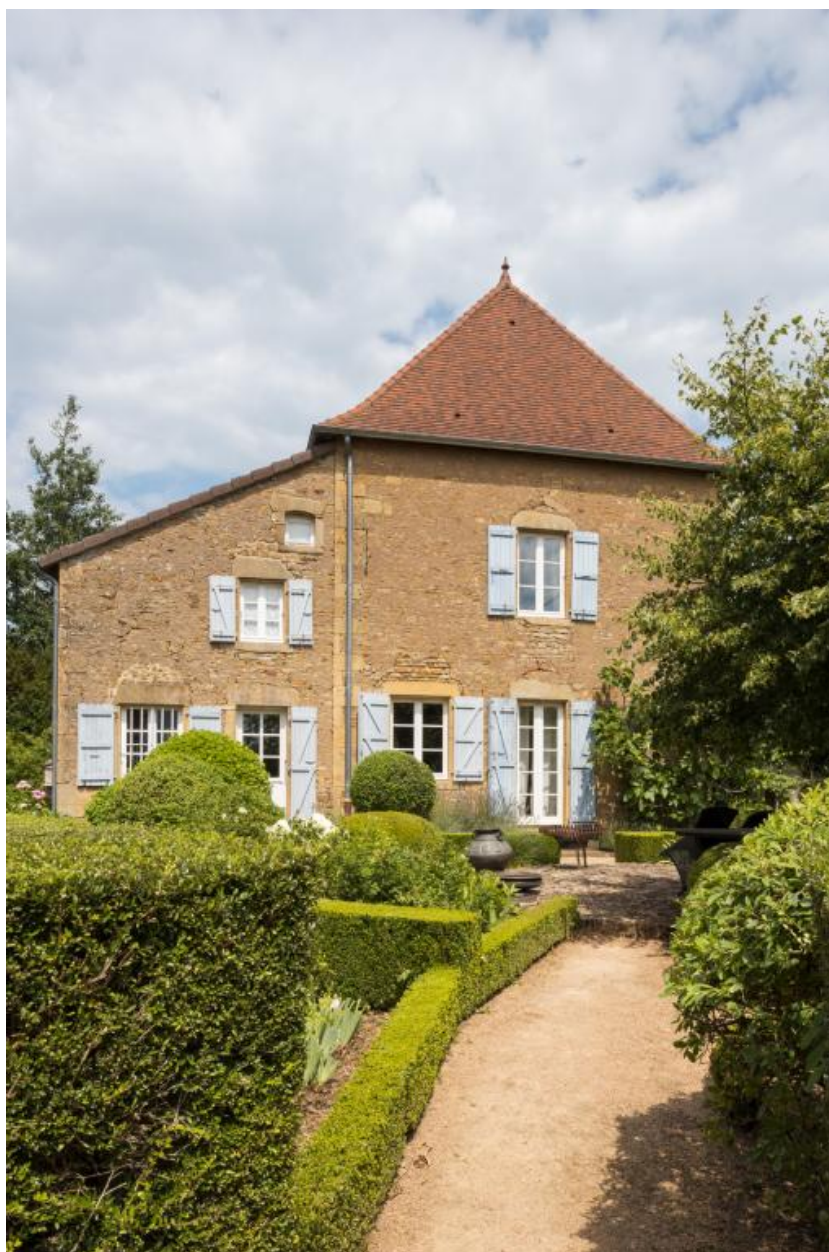
Façade latérale ouest de la maison
