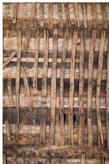
Détail d'un plancher dans la dépendance, constitué de pièces de bois (solives), de bottes de paille et couvert d'un lattis Phot. Pierre-Marie Barbe-Richaud IVR26_20187100277NUC4A
