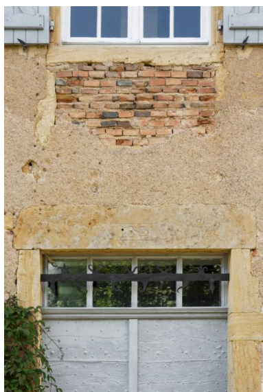
Linteau de la porte de la maison portant la date de 1821 et détail de la maçonnerie en brique sous les assises de fenêtres Phot. Pierre-Marie Barbe-Richaud IVR26_20187100267NUC4A
