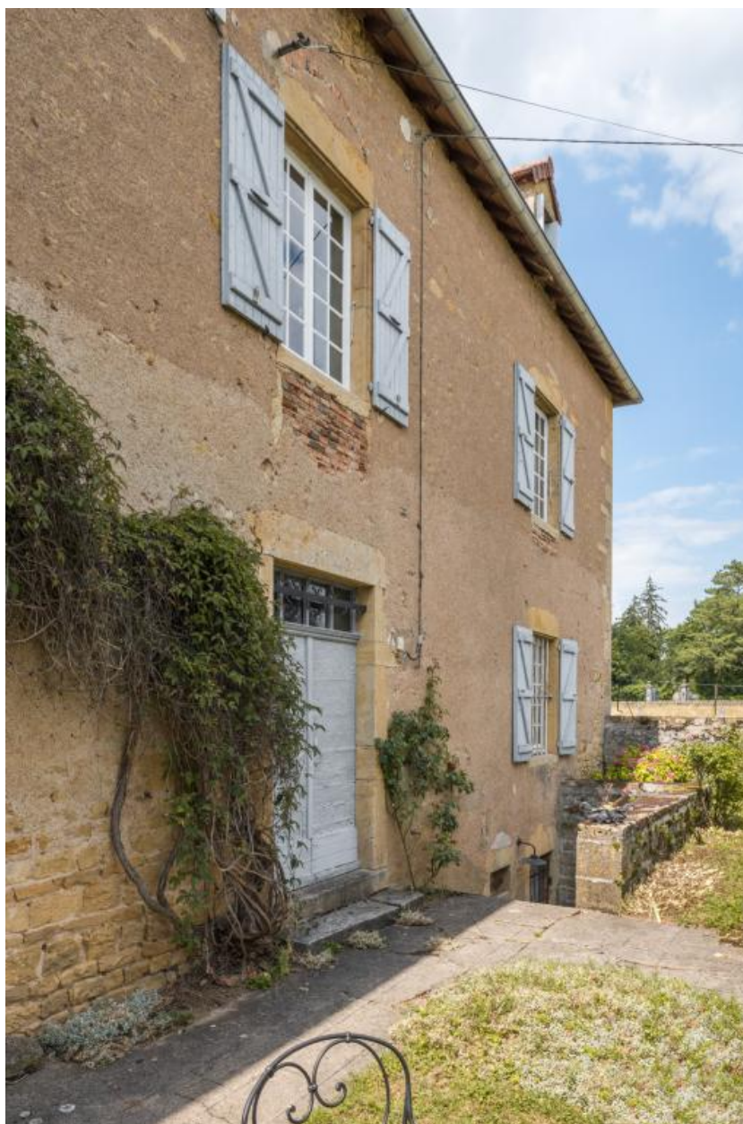
Façade antérieure de la maison
