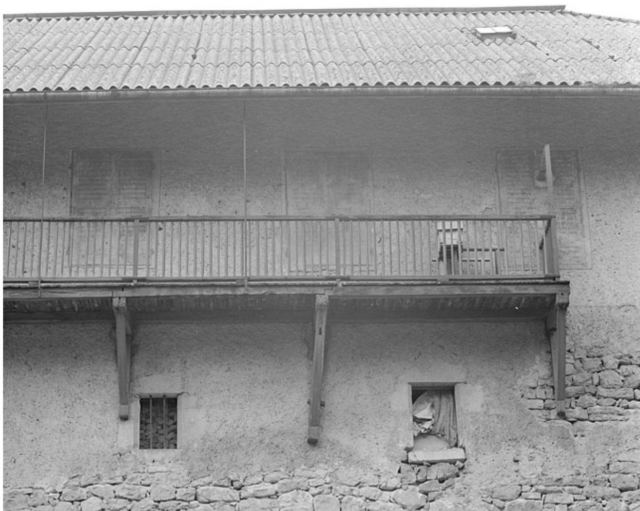
Détail de la façade postérieure.
