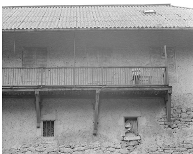
Détail de la façade postérieure. Phot. Jérôme Mongreville IVR43_19963901001X
