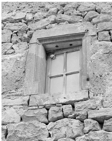
Détail d'une fenêtre sur la façade postérieure. Phot. Jérôme Mongreville IVR43_19963901002X
