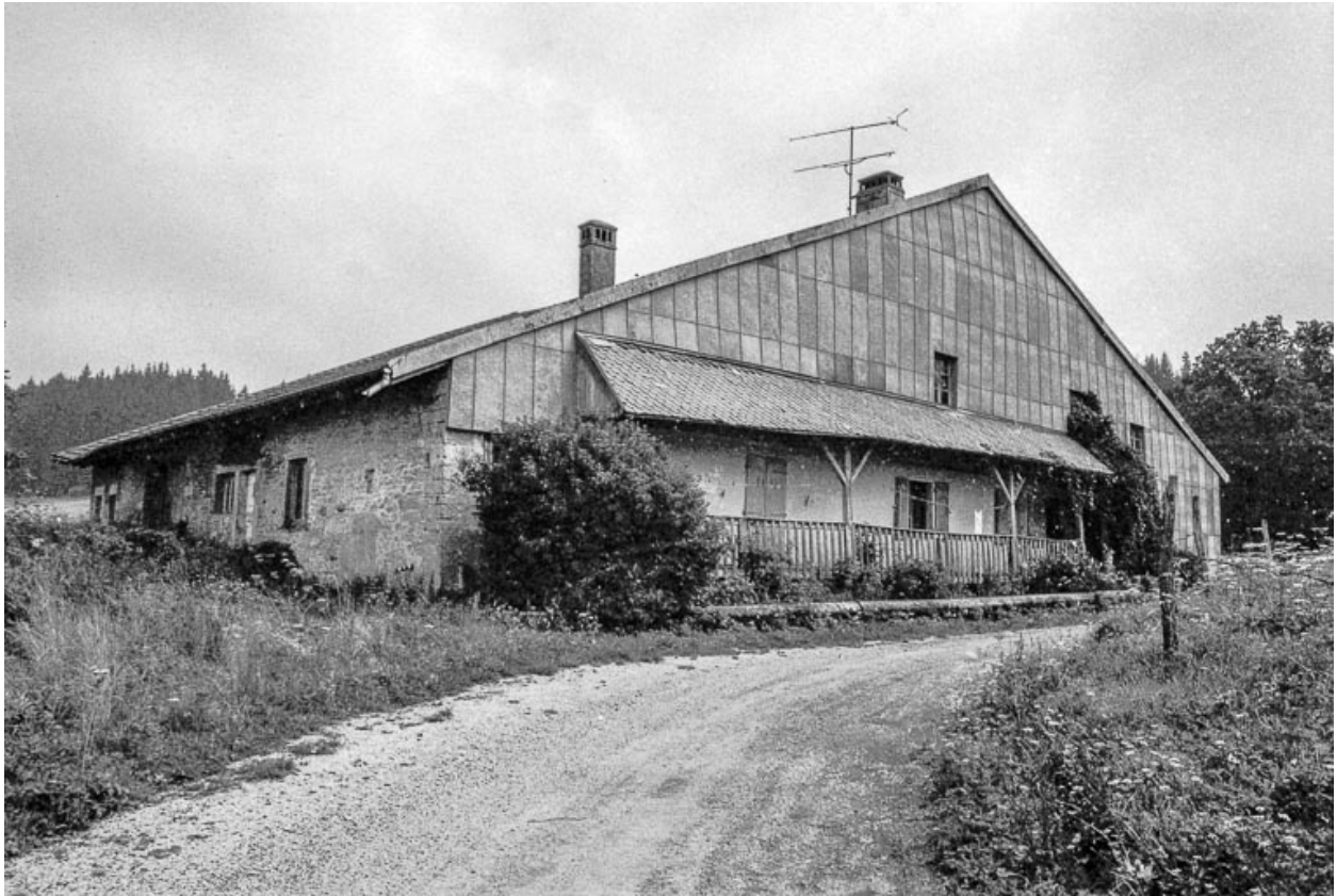
Ferme située au lieudit Montorge.
