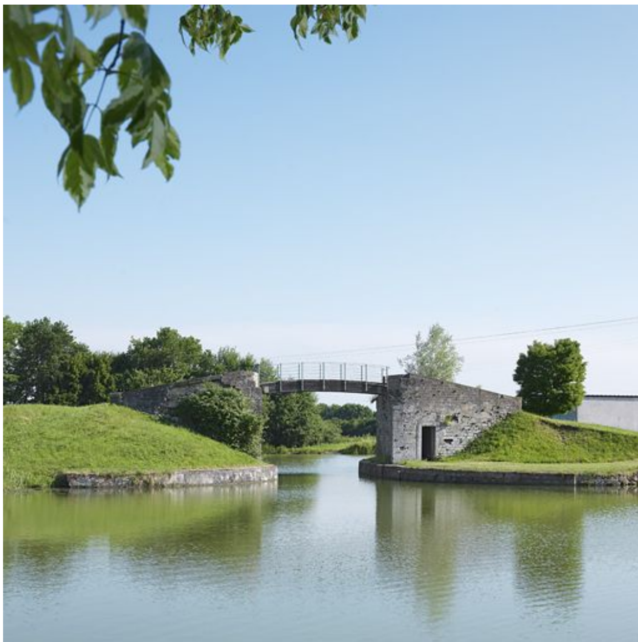
Vue de la passerelle haute, de face.
