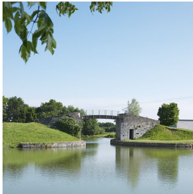
Vue de la passerelle haute, de face. Phot. Thierry Kuntz IVR26_20135800317NUC4A
