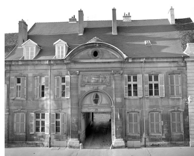
Façade antérieure de l'hôtel, vue de face. Phot. Yves Sancey IVR43_19893900585X
