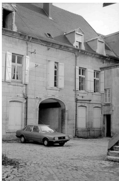
Façade postérieure de l'hôtel. Phot. Laurent Poupard
