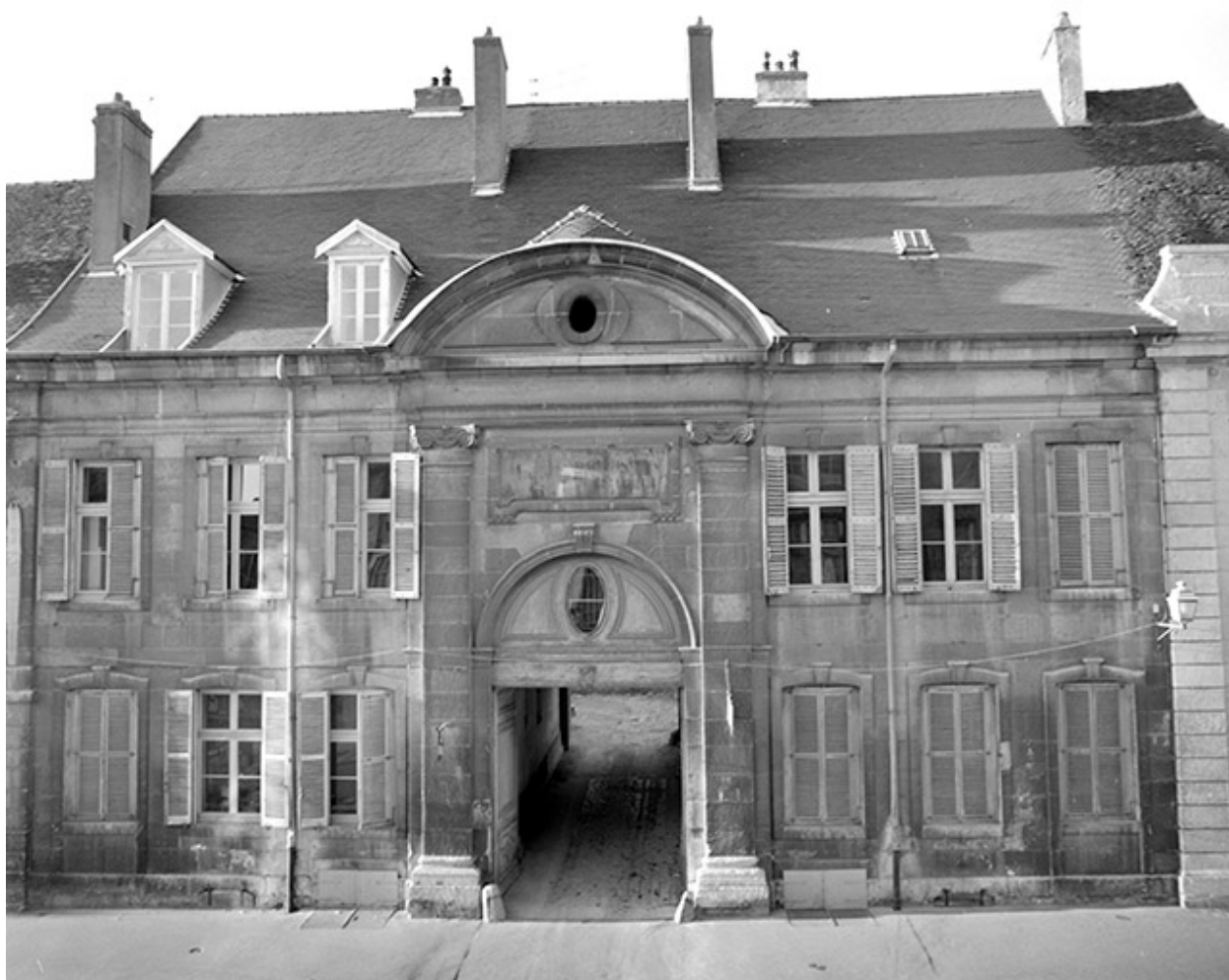
Façade antérieure de l'hôtel, vue de face.
