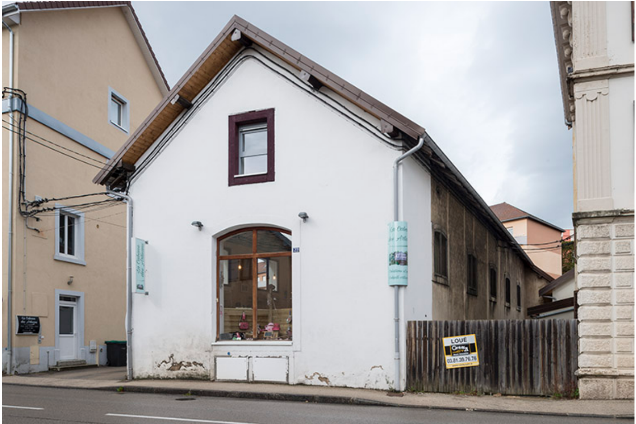
Pignon et façade nord.
