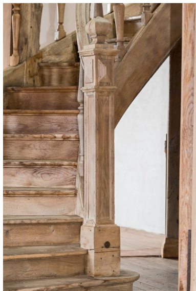
Départ de rampe. Phot. Pierre-Marie Barbe-Richaud IVR26_20212100468NUC4A
