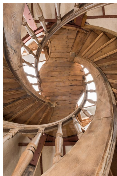
Montées vues par dessous.
