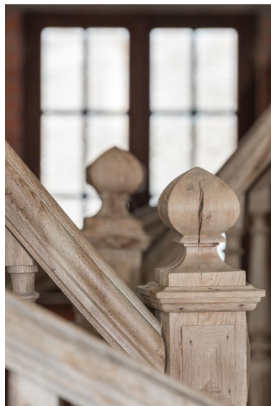
Partie supérieure du départ de rampe : amortissement. Phot. Pierre-Marie Barbe-Richaud IVR26_20212100473NUC4A
