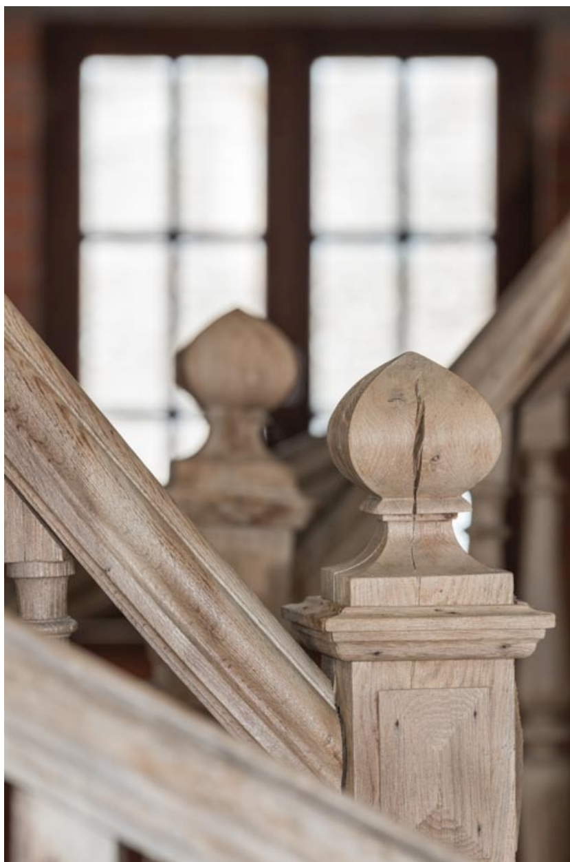
Partie supérieure du départ de rampe : amortissement.
