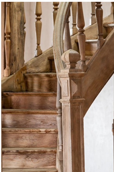
Partie supérieure du départ de rampe : décor. Phot. Pierre-Marie Barbe-Richaud IVR26_20212100469NUC4A
