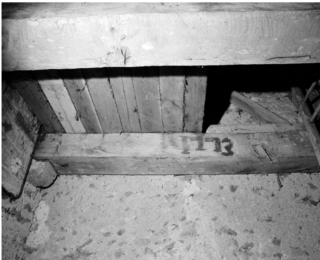
Clocher, poutres supportant le beffroi.
