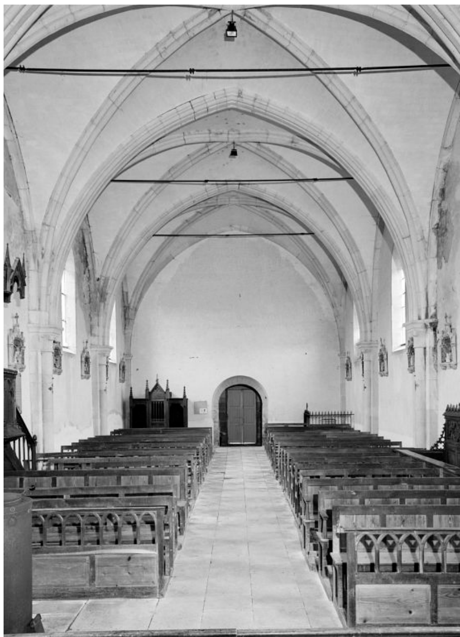
Vue intérieure prise du chœur.
