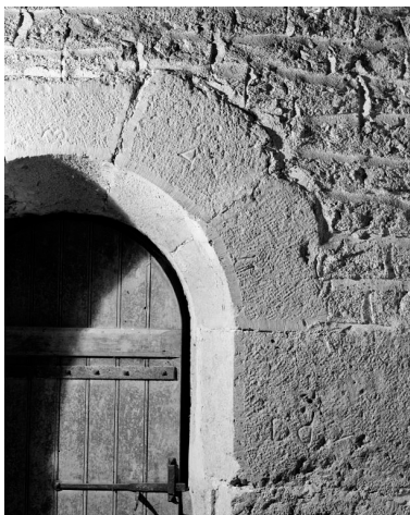
Clocher, 2e niveau : détail de la fenêtre gauche (transformée en porte).
