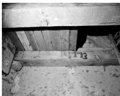
Clocher, poutres supportant le beffroi.
