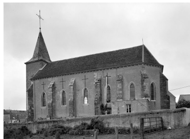
Elévation droite. Phot. Jean-Luc Duthu IVR26_19955801121V
