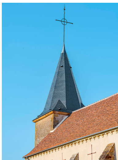
Détail de la couverture en tuiles plates restaurée et du clocher. Phot. Thierry Kuntz IVR26_20245800003NUC4A
