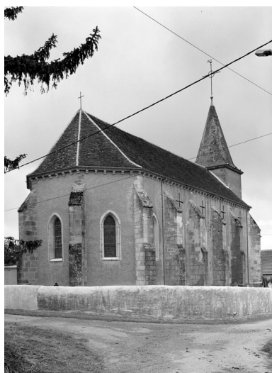
Elévation gauche et abside Phot. Jean-Luc Duthu IVR26_19955801119V
