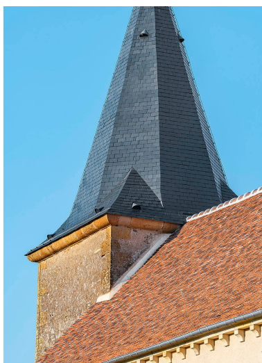
Détail de la couverture en tuiles plates refaite. Phot. Thierry Kuntz IVR26_20245800004NUC4A
