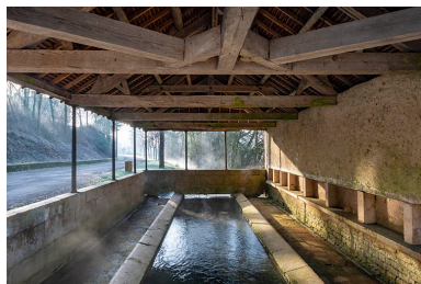
Élévation intérieure. Phot. Jérôme Mongreville IVR43_20197000107NUC4A
