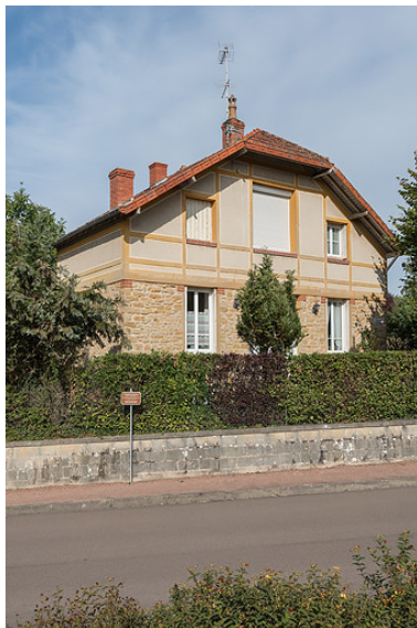
Façade sur l'avenue Eugène Collin. Phot. Pierre-Marie Barbe-Richaud IVR26_20195800700NUC4A
