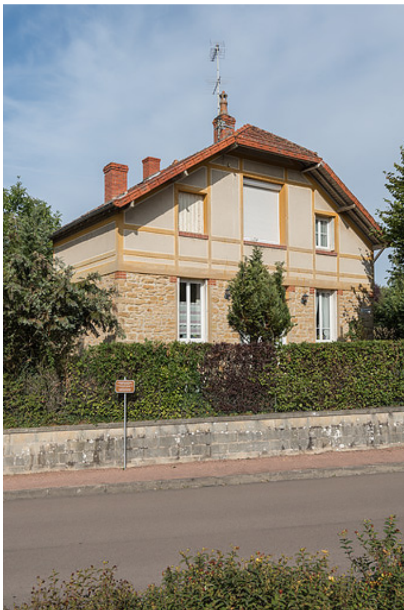
Façade sur l'avenue Eugène Collin.
