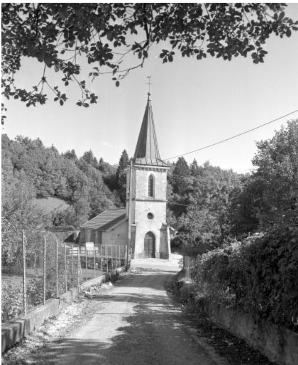
Extérieur : façade occidentale.
