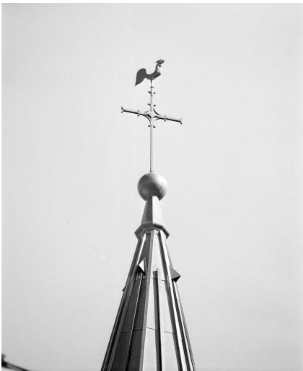
Extérieur : le sommet de la flèche.
