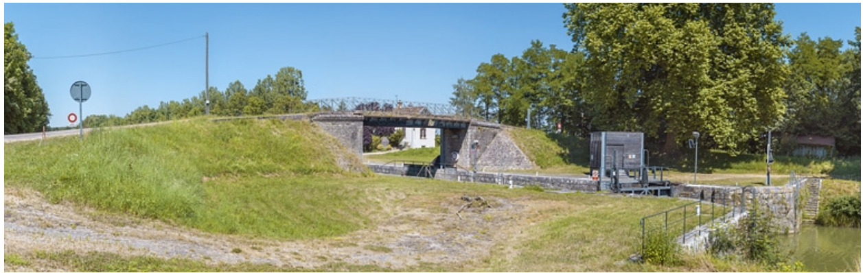
Vue d'ensemble du site d'écluse.
