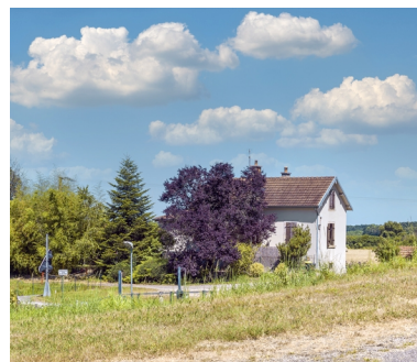
La maison éclusière de Poncey.
