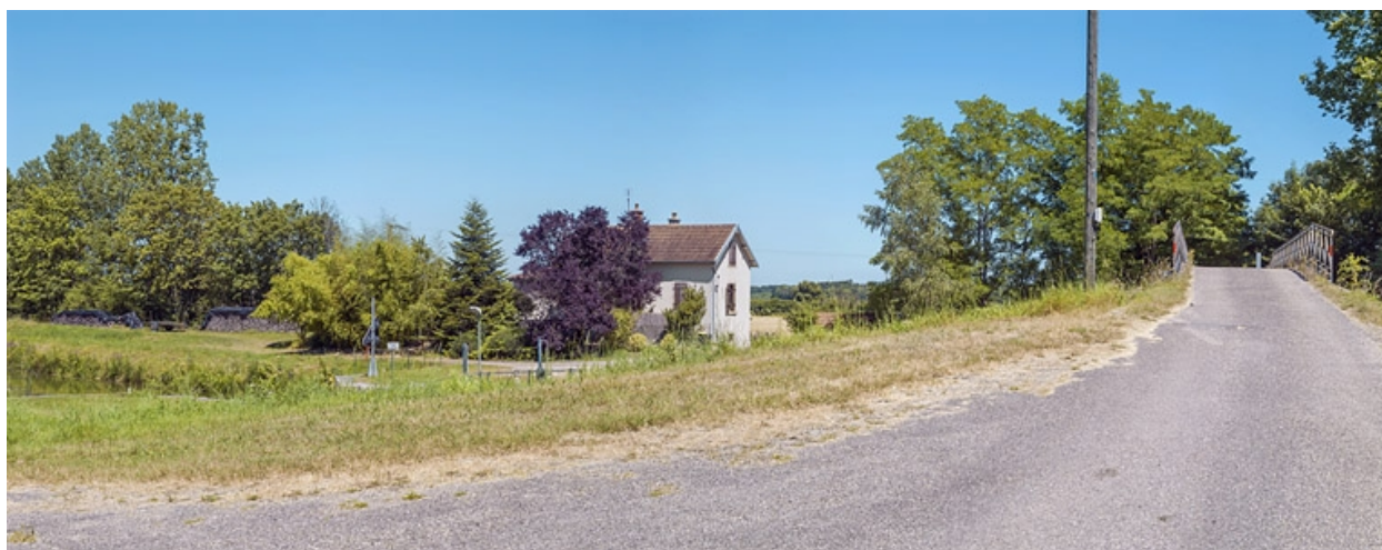
La maison éclusière.
