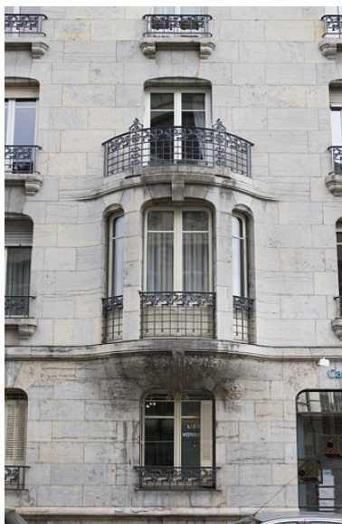
Façade latérale gauche : détail du bow-window.
