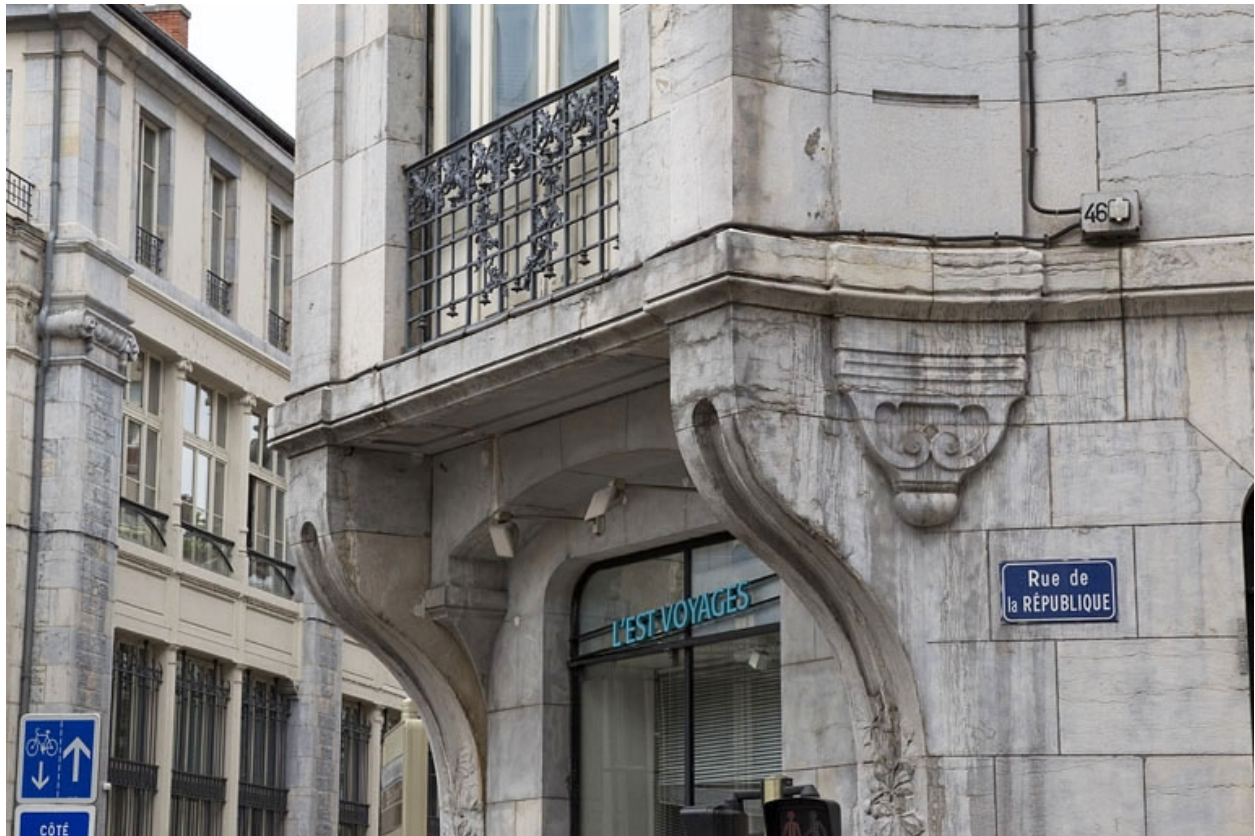
Façade d'angle : détail du rez-de-chaussée.
