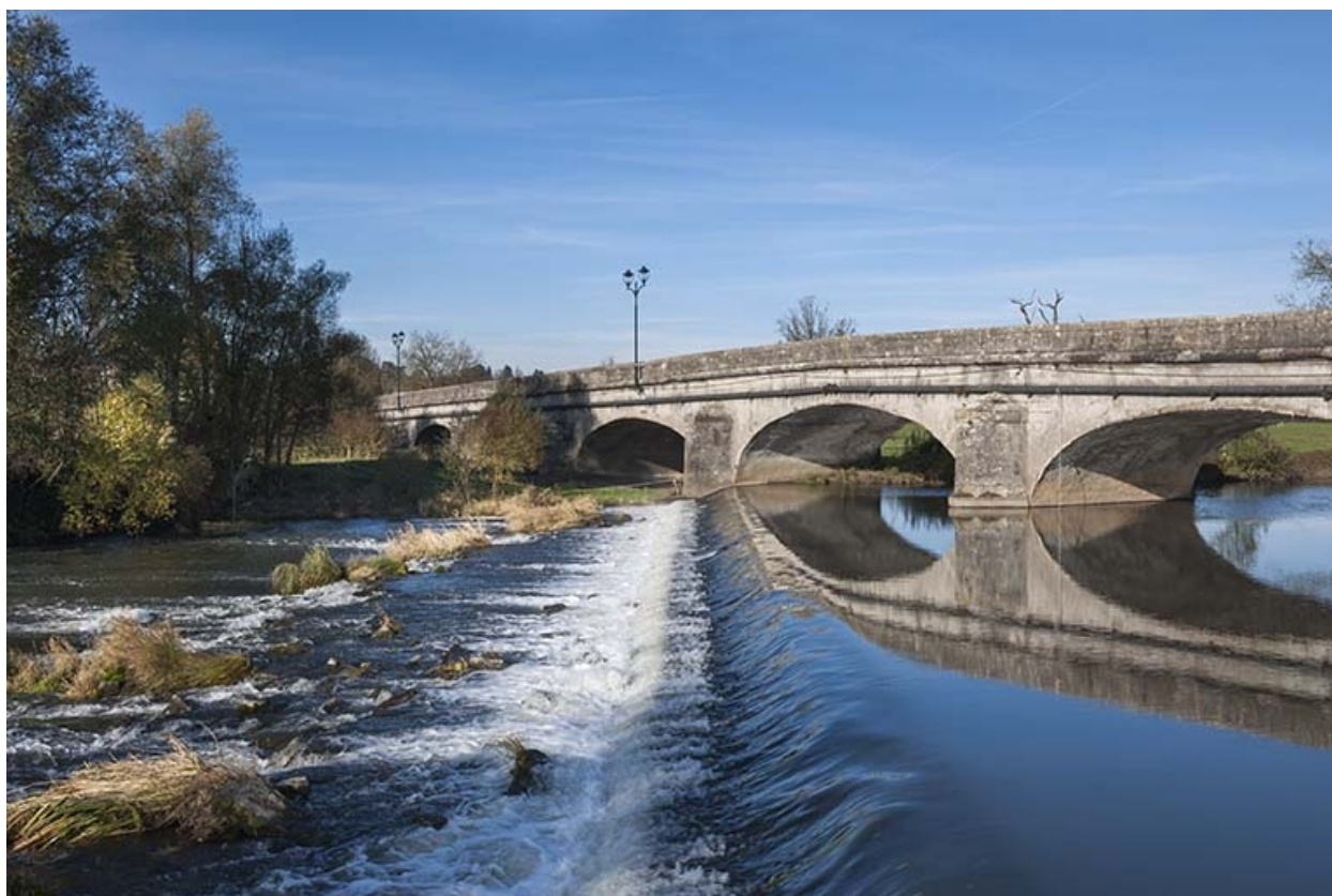
Vue générale depuis l'aval avec le barrage.
