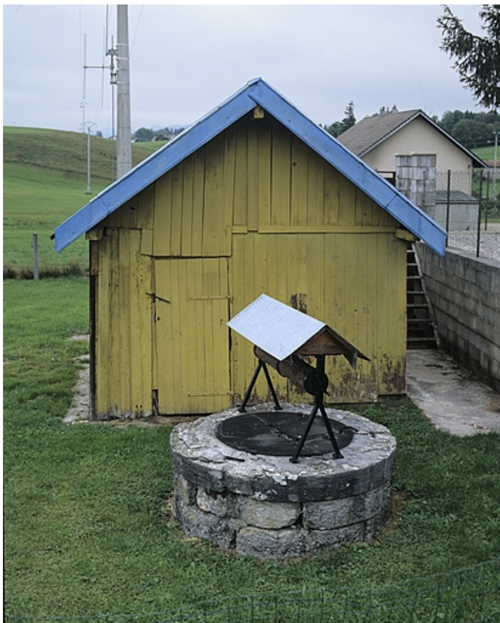
Puits et dépendance.
