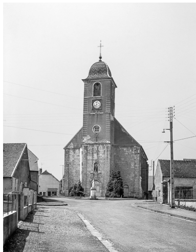
Façade antérieure avec tour-clocher. Phot. Yves Sancey IVR43_19837000071V
