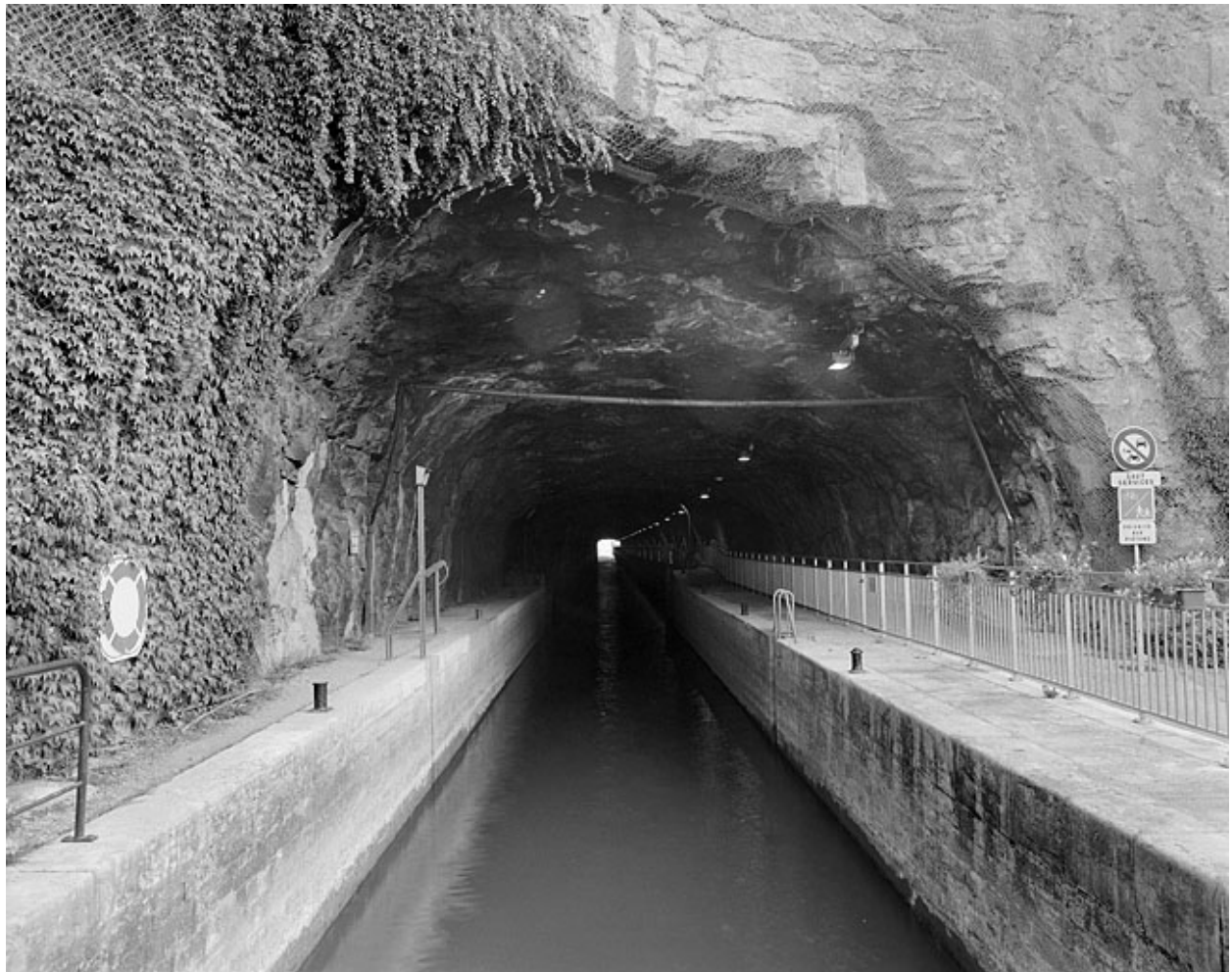
Sas de l'écluse, depuis l'aval.
