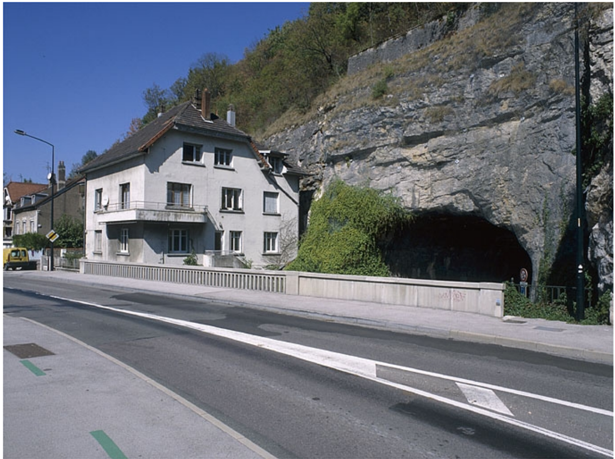
Pont routier et maison d'éclusier.
