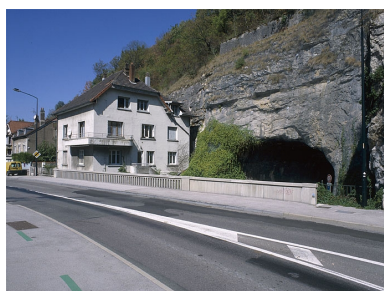
Pont routier et maison d'éclusier. Phot. Jérôme Mongreville IVR43_20032500150XA
