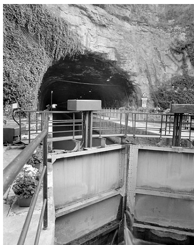
Porte aval de l'écluse et tunnel. Phot. Jérôme Mongreville IVR43_20032500154X
