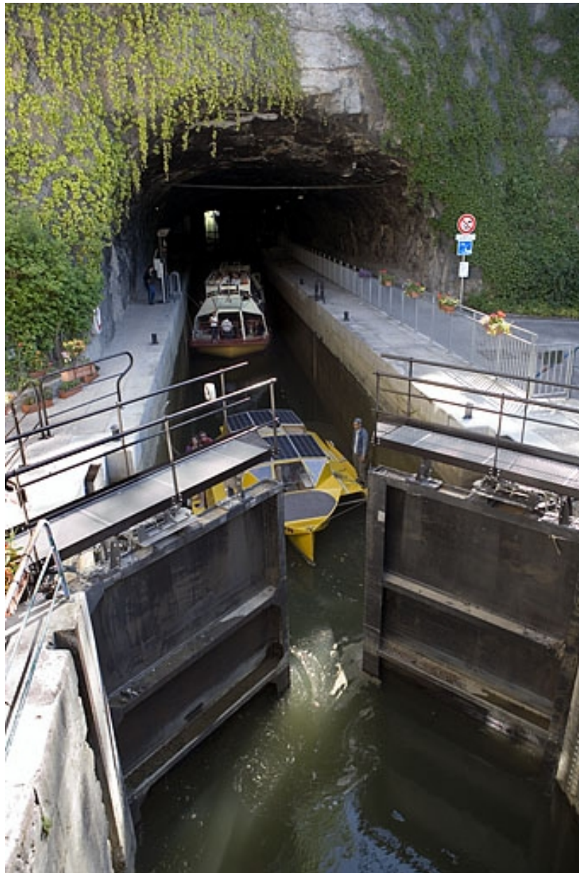
Eclusage : ouverture de la porte aval.
