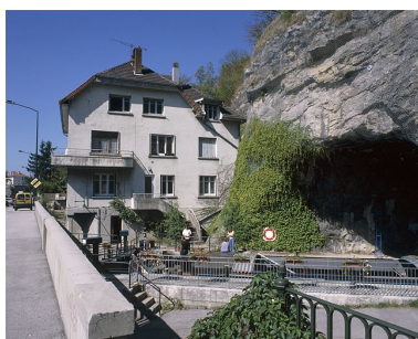
Maison d'éclusier et écluse. Phot. Jérôme Mongreville IVR43_20032500152XA
