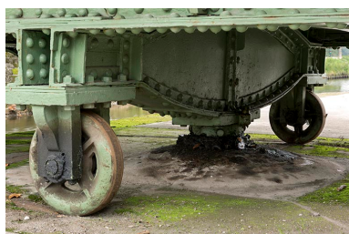
Détail du pivot sous le chevêtre.
