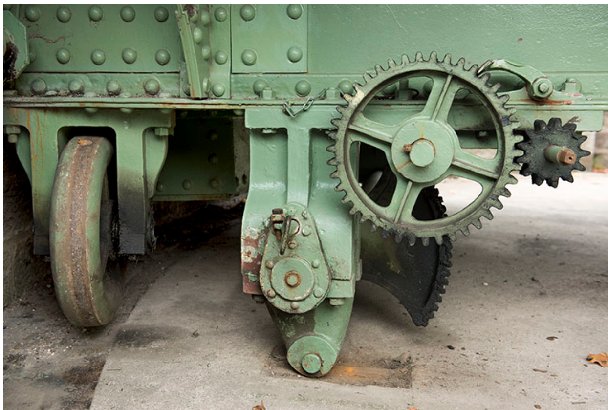
Détail du système de calage du pont.
