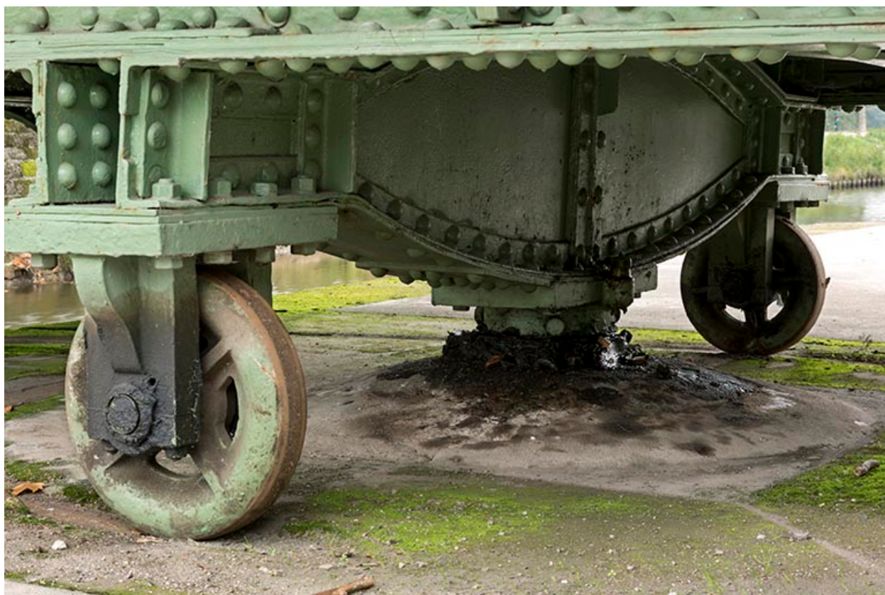
Détail du pivot sous le chevêtre.
