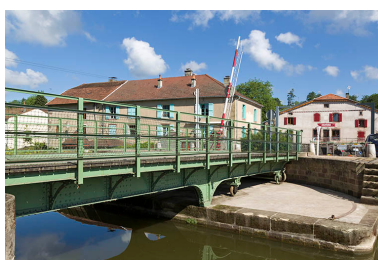
Le tablier métallique et sa plateforme. Phot. Sonia Dourlot IVR43_20157000983NUC2A
