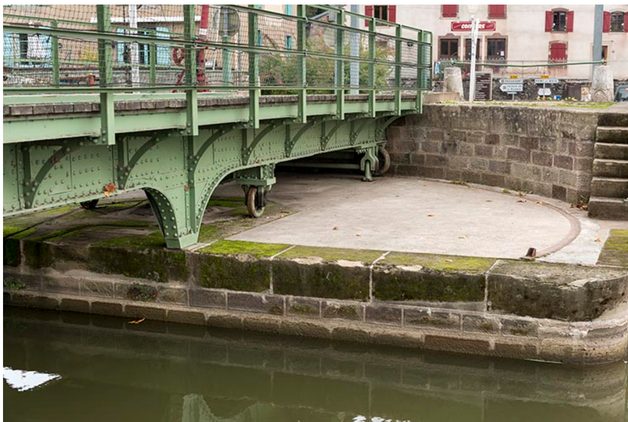
Détail de la plateforme maçonnée.
