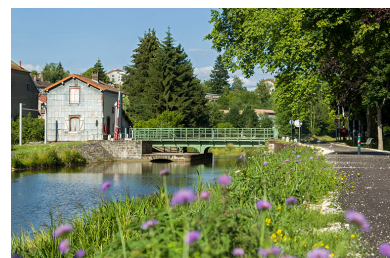
Le pont tournant depuis l'aval. Phot. Sonia Dourlot IVR43_20157000978NUC2A
