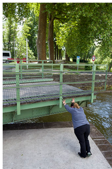
Rotation du pont par poussée manuelle. Phot. Sonia Dourlot IVR43_20157000988NUC2A
