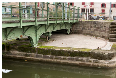
Détail de la plateforme maçonnée.
