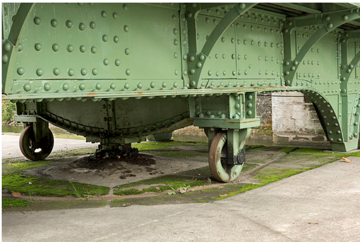
Roues, pivot et chevêtre.
