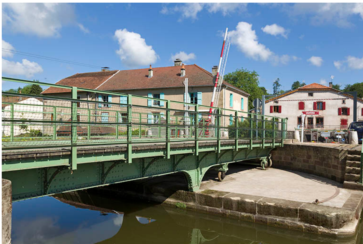
Le tablier métallique et sa plateforme.
