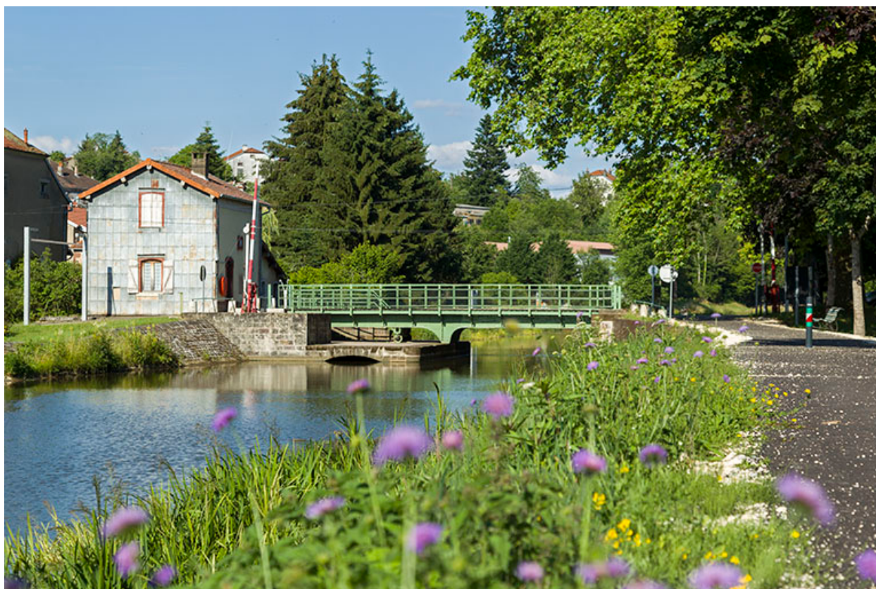
Le pont tournant depuis l'aval.
