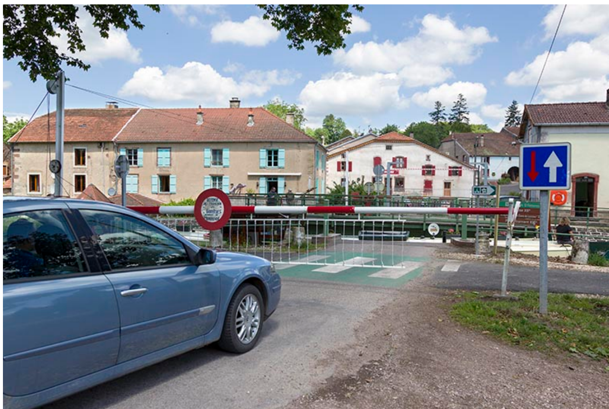
Fermeture du pont à la circulation routière.
