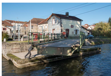
Rotation du tablier métallique.
