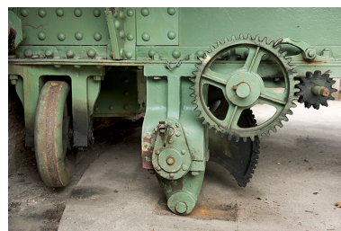
Détail du système de calage du pont.
