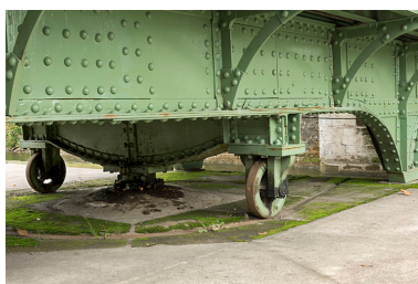
Roues, pivot et chevêtre.
