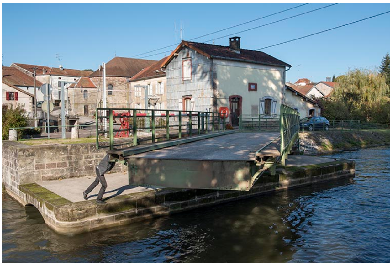
Rotation du tablier métallique.
