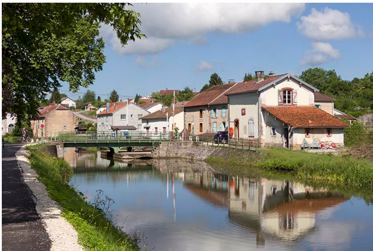
Vue d'ensemble depuis l'amont.
