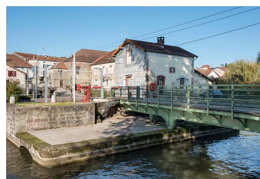
Remise en place du tablier métallique.
