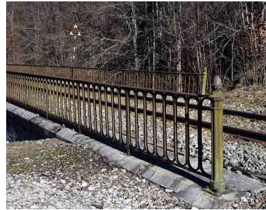
Extrémité du garde-corps métallique.
