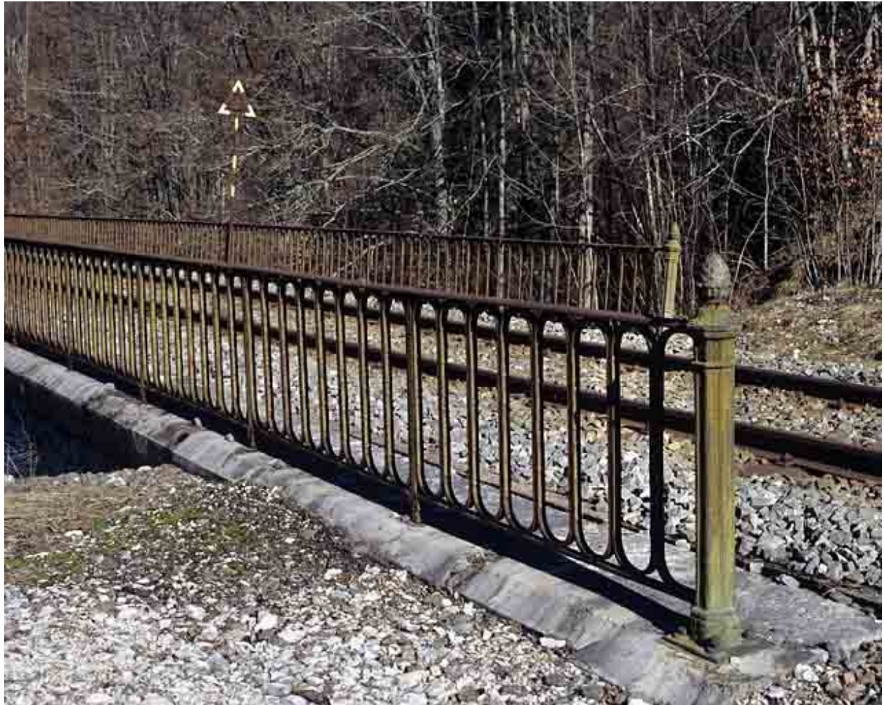
Extrémité du garde-corps métallique.
