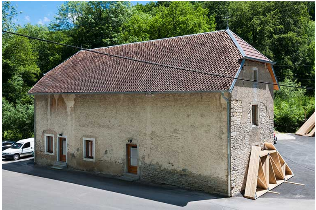
Bâtiment agricole vu de trois quarts.
