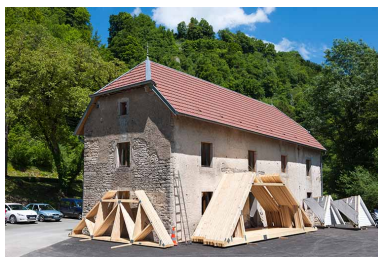
Bâtiment agricole depuis le sud-ouest. Phot. Jérôme Mongreville IVR43_20132500661NUC4A
