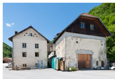
Pignons est du moulin et du logement. Phot. Jérôme Mongreville IVR43_20132500662NUC4A
