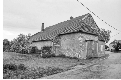
Façade postérieure. Phot. Bernard Lardière IVR43_19817000276Z
