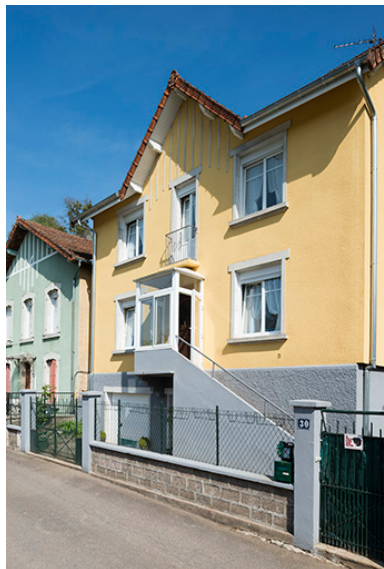
Vue générale. Phot. Jérôme Mongreville IVR43_20177000508NUC4A
