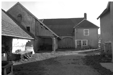
Vue d'ensemble depuis la cour. Phot. Yves Sancey IVR43_19847000039X
