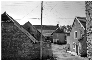
Vue d'ensemble depuis la rue. Phot. Bernard Lardière IVR43_19817000639Z
