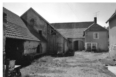
Habitation et parties agricoles. Phot. Bernard Lardière IVR43_19817000641Z
