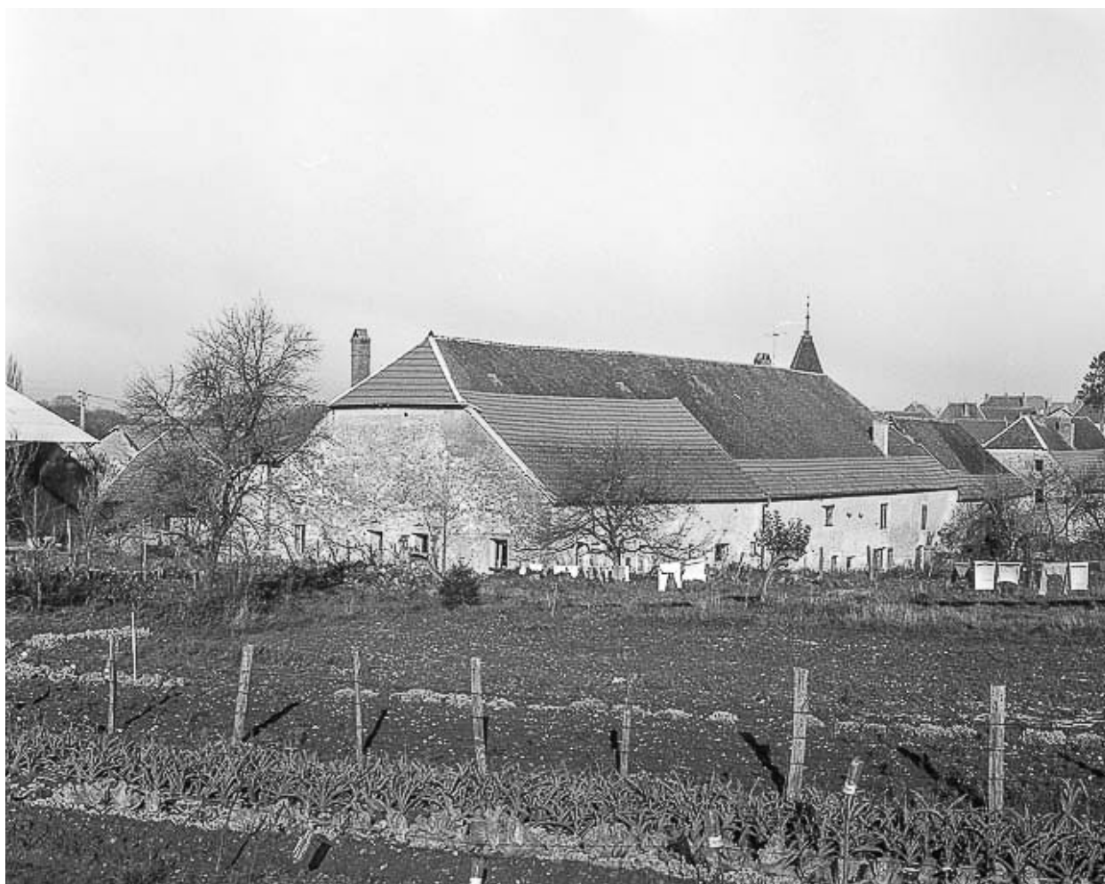
Façade postérieure : vue éloignée
