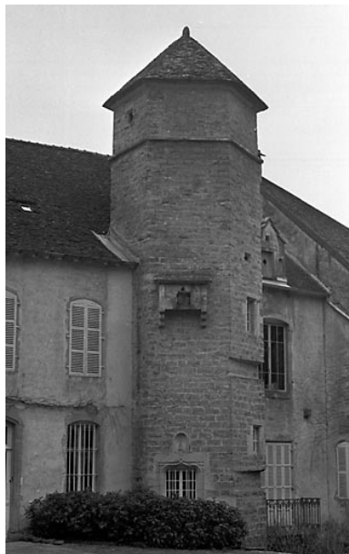
Détail de la façade antérieure. Phot. Guy Forestier IVR43_19743900323Z
