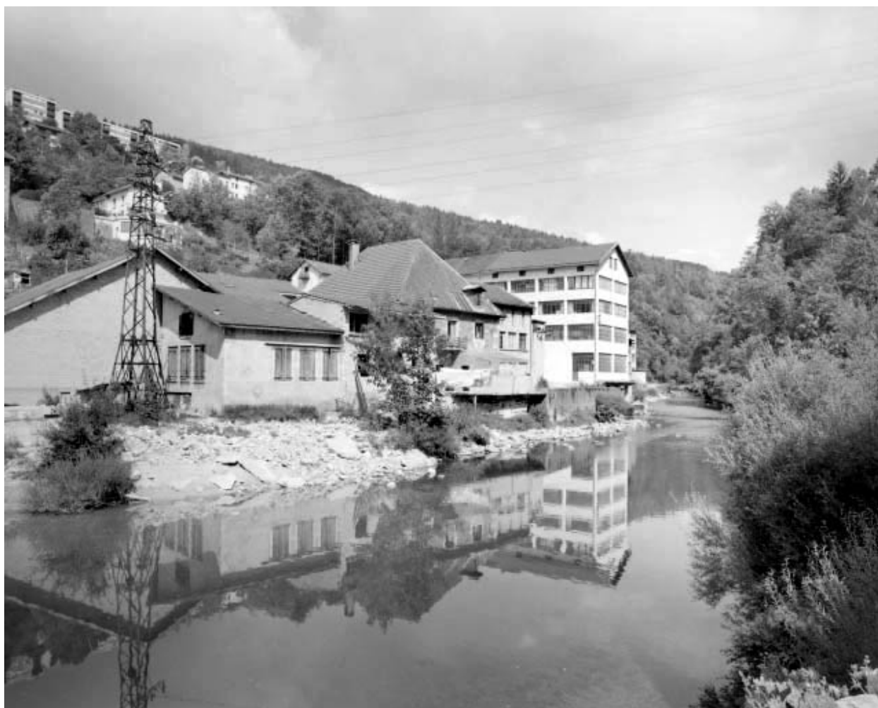
Façade postérieure des bâtiments, depuis l'aval.
