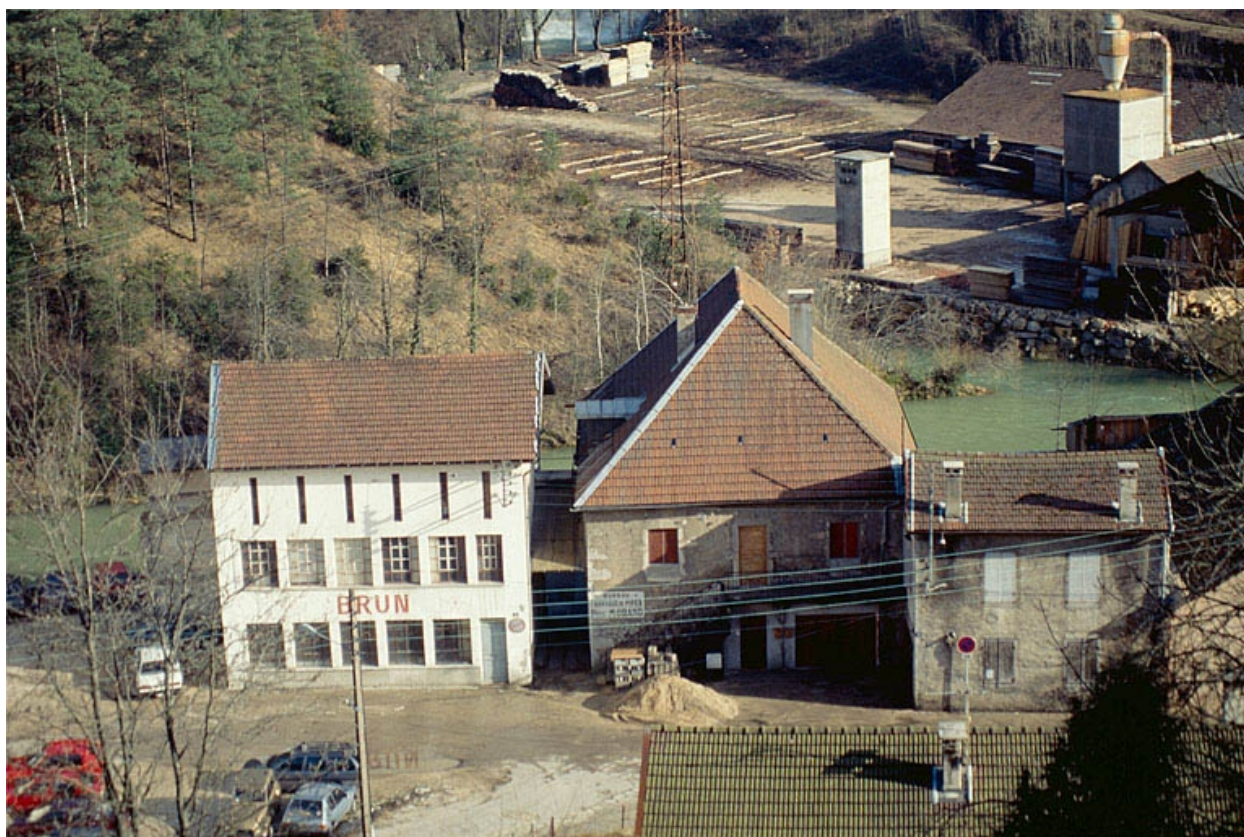
Façade antérieure des bâtiments.
