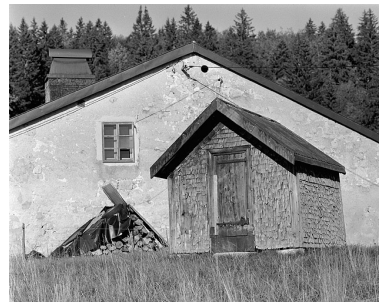
Le grenier fort. Phot. Jérôme Mongreville IVR43_19963901476X
