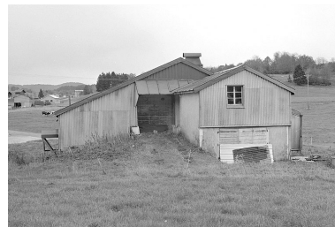
Face sud-ouest. Phot. Jérôme Mongreville IVR43_19963901477X
