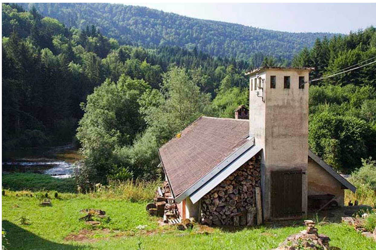
Centrale : façade latérale droite et transformateur.
