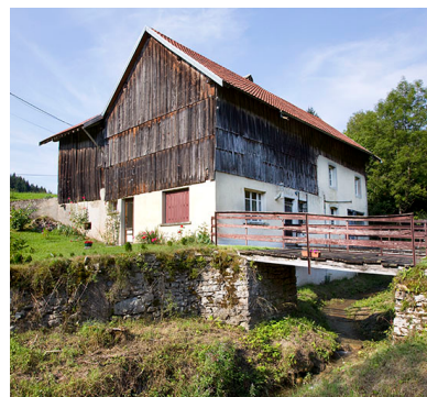
Scierie : façades postérieure et latérale droite.
