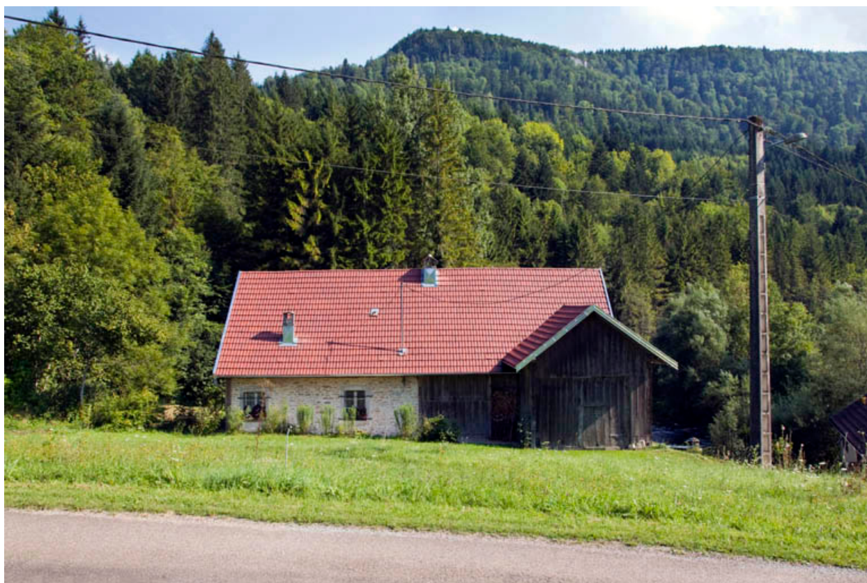
Scierie : façade antérieure.
