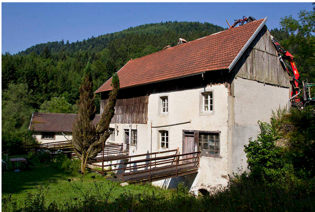
Scierie : façades postérieure et latérale gauche.
