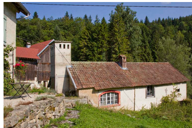
Centrale : façade postérieure, de trois quarts gauche.
