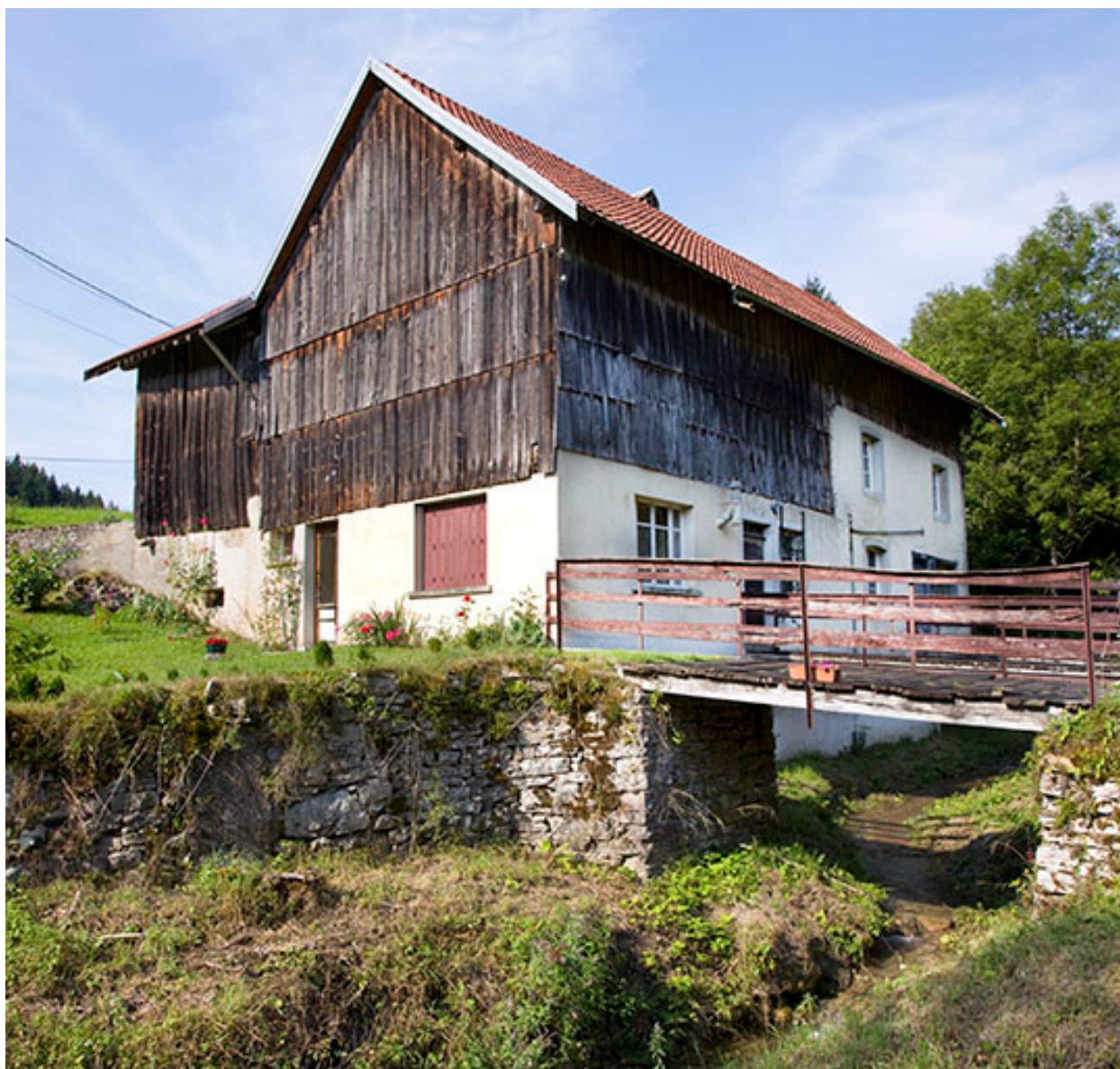
Scierie : façades postérieure et latérale droite.
