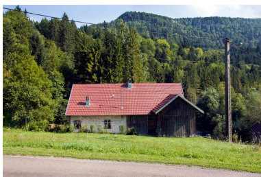
Scierie : façade antérieure.
