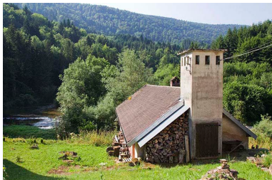
Centrale : façade latérale droite et transformateur.
