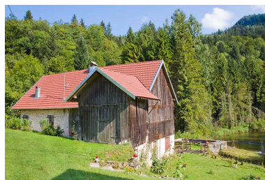
Scierie : façades antérieure et latérale droite.
