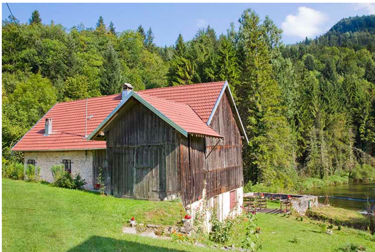
Scierie : façades antérieure et latérale droite.
