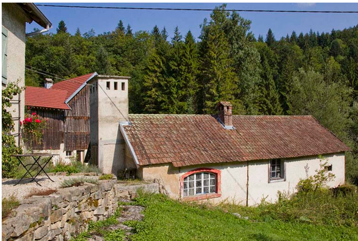
Centrale : façade postérieure, de trois quarts gauche.
