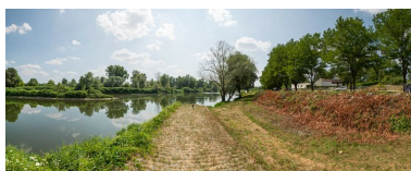
Le reste de bajoyer à la sortie du canal dans la Loire, à gauche. Phot. Pierre-Marie Barbe-Richaud IVR26_20137100556NUC2AQ
