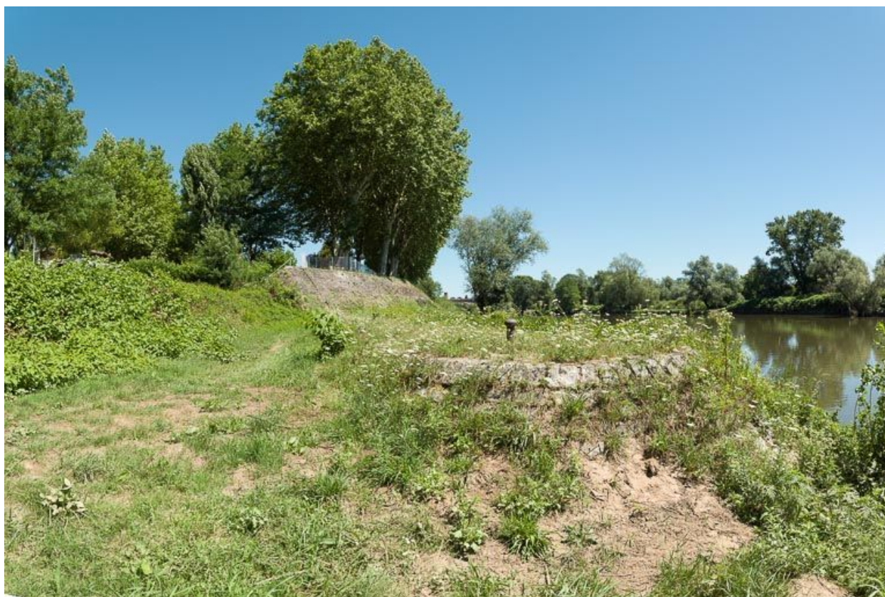
L'ancien bajoyer et la Loire.
