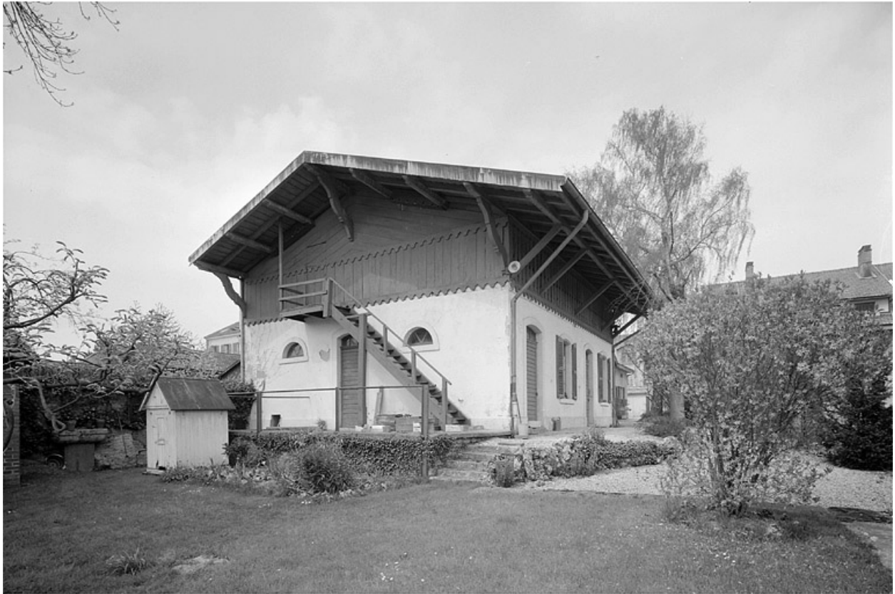
Remise à voitures. Façades sud et est.
