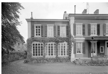
Façade sur jardin. Aile ouest. Phot. Jérôme Mongreville IVR43_19872501255V
