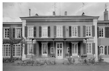
Façade sur jardin. Partie centrale. Phot. Jérôme Mongreville IVR43_19872501254V
