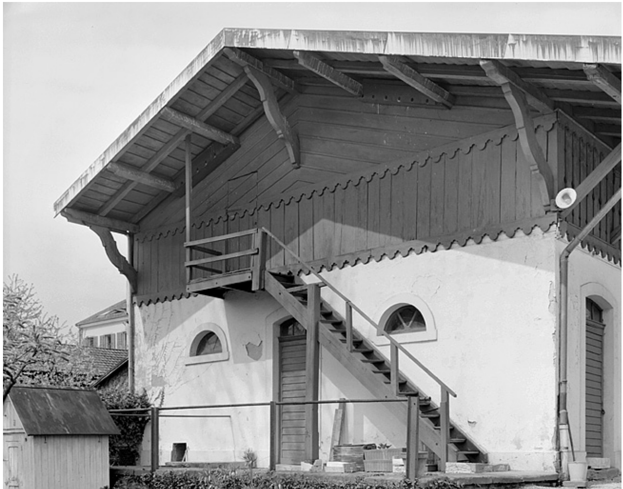
Remise à voitures. Façade sud.
