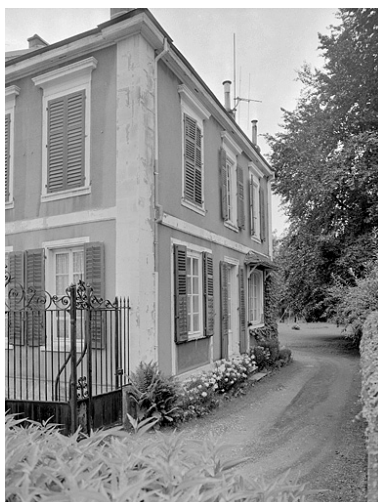
Façade latérale ouest. Phot. Jérôme Mongreville IVR43_19872500516X
