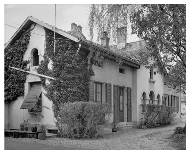
Anciennes écuries. Façades sud et est. Phot. Jérôme Mongreville IVR43_19882500085V
