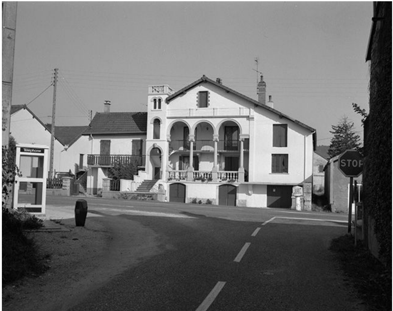
Façade antérieure vue de face.
