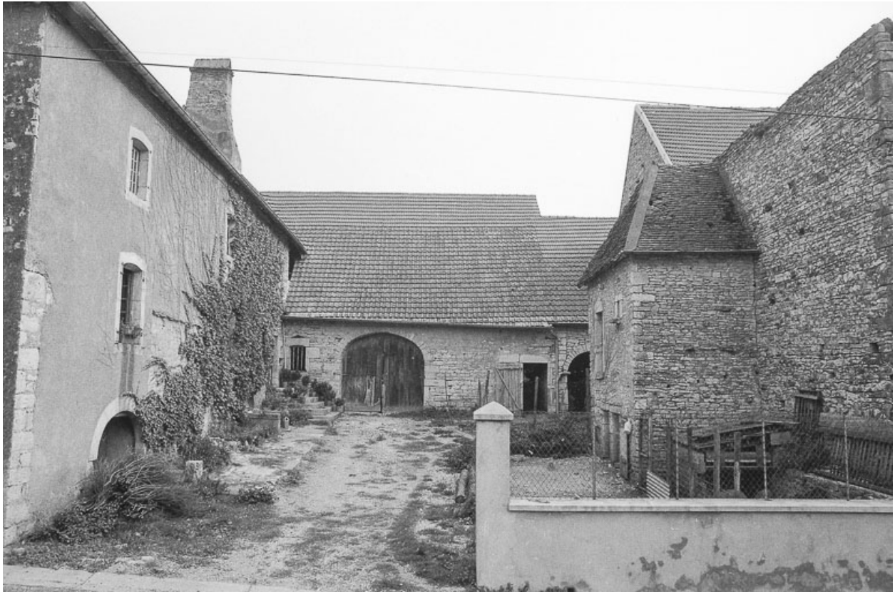
Façades sur cour.
