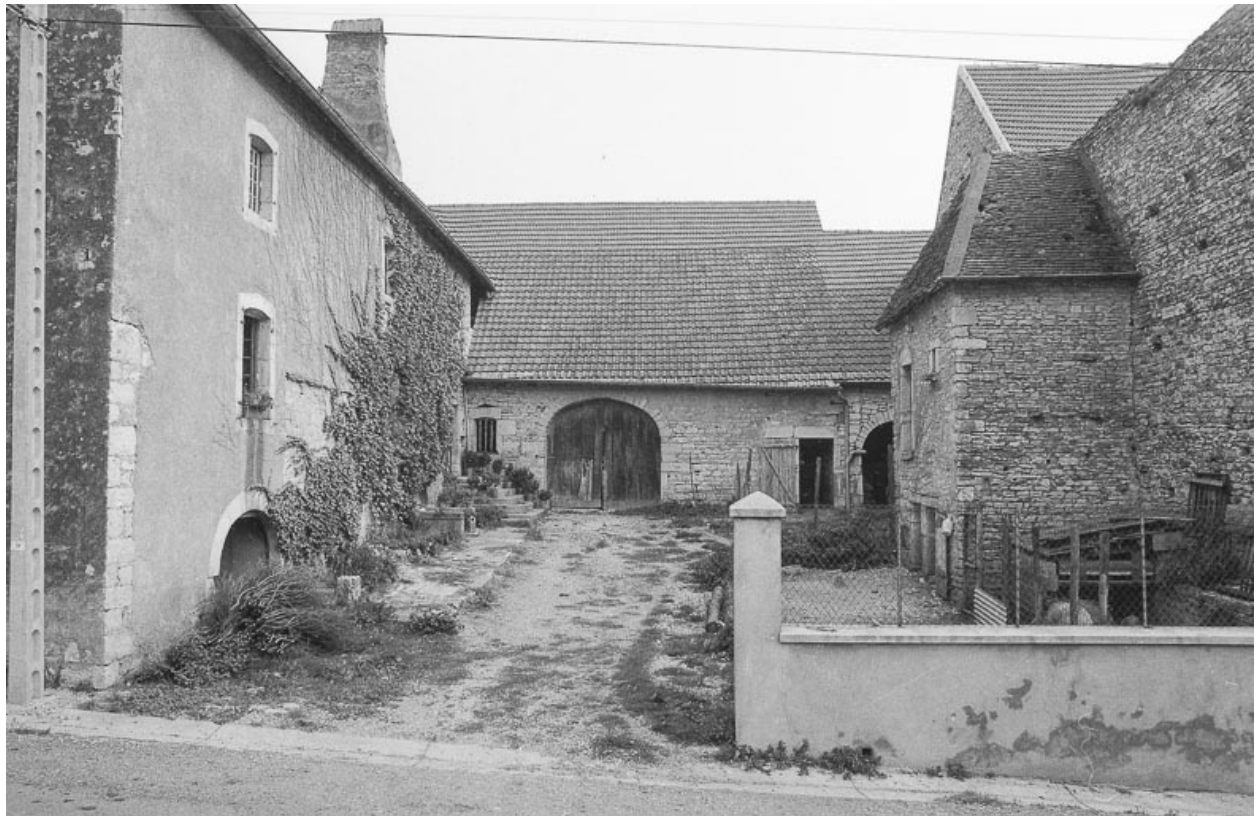
Façades sur cour.
