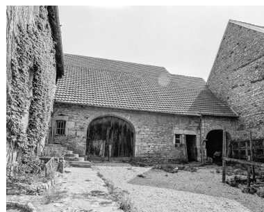
Dépendances et escaliers menant à l'habitation. Phot. Dominique Humbert IVR43_19767000494X
