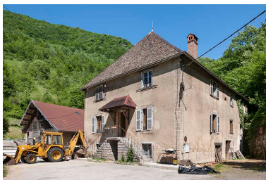
Atelier de scierie et logement patronal. Phot. Jérôme Mongreville IVR43_20152501271NUC4A
