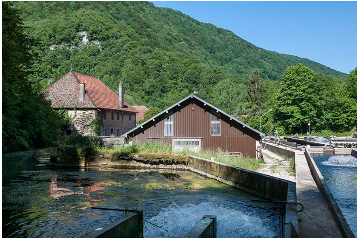
Vue depuis l'emplacement du bassin de retenue.
