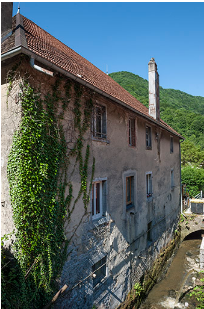
Façade nord du logement (ancien atelier).
