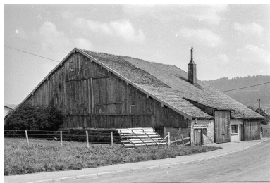
Ferme cadastrée 1973 ZE 31a : façade postérieure. Phot. Gilbert Poinot IVR43_19752501298Z
