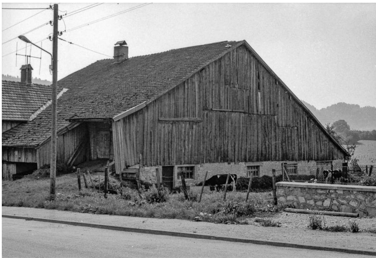
Ferme : façade latérale droite.
