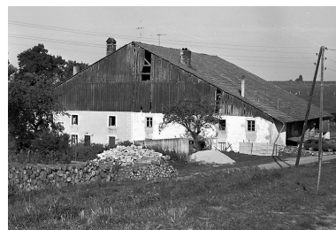
Ferme située au lieudit Pissenvache : vue d'ensemble. Phot. Bernard Lardière IVR43_19782500316X
