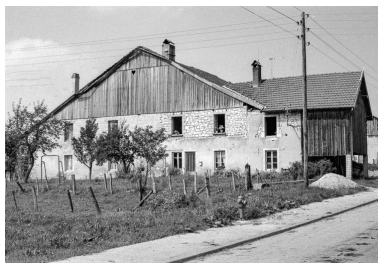
Ferme : façade antérieure. Phot. Gilbert Poinot IVR43_19752501455Z
