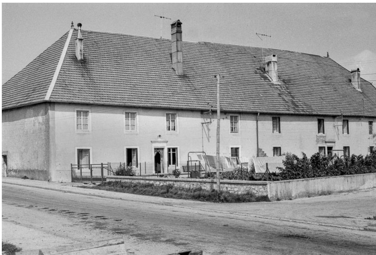
Maison cadastrée 1973 ZE 48 : façade antérieure.
