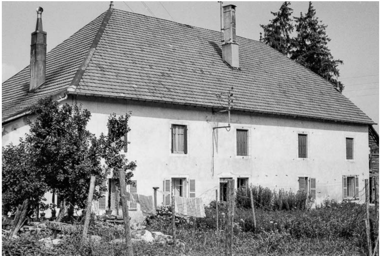
Ferme cadastrée 1964 D 25, 31, 31 bis, 33 : façade antérieure.
