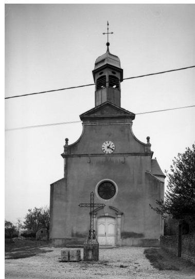
Elévation antérieure Phot. Michel Rosso IVR26_19852101416V
