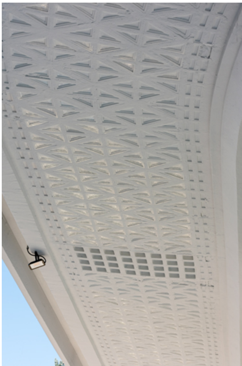
Face inférieure de l'auvent en béton armé.
