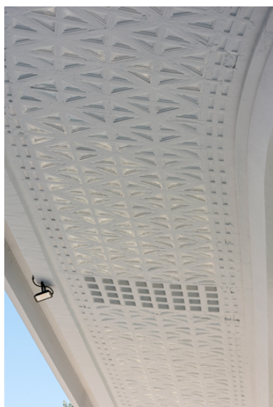
Face inférieure de l'auvent en béton armé. Phot. Pierre-Marie Barbe-Richaud IVR26_20232100020NUC4A
