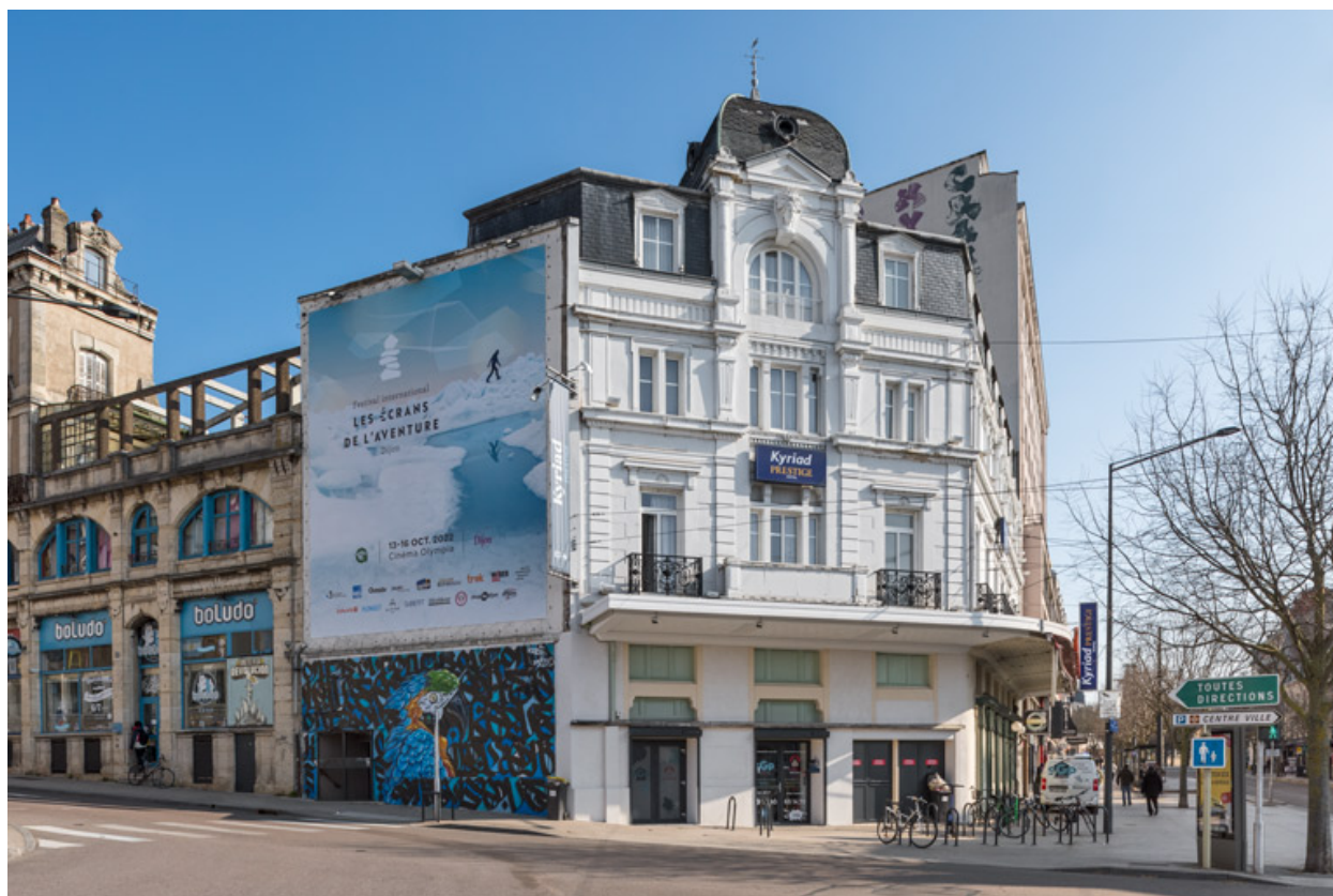
Façades antérieure et latérale gauche.
