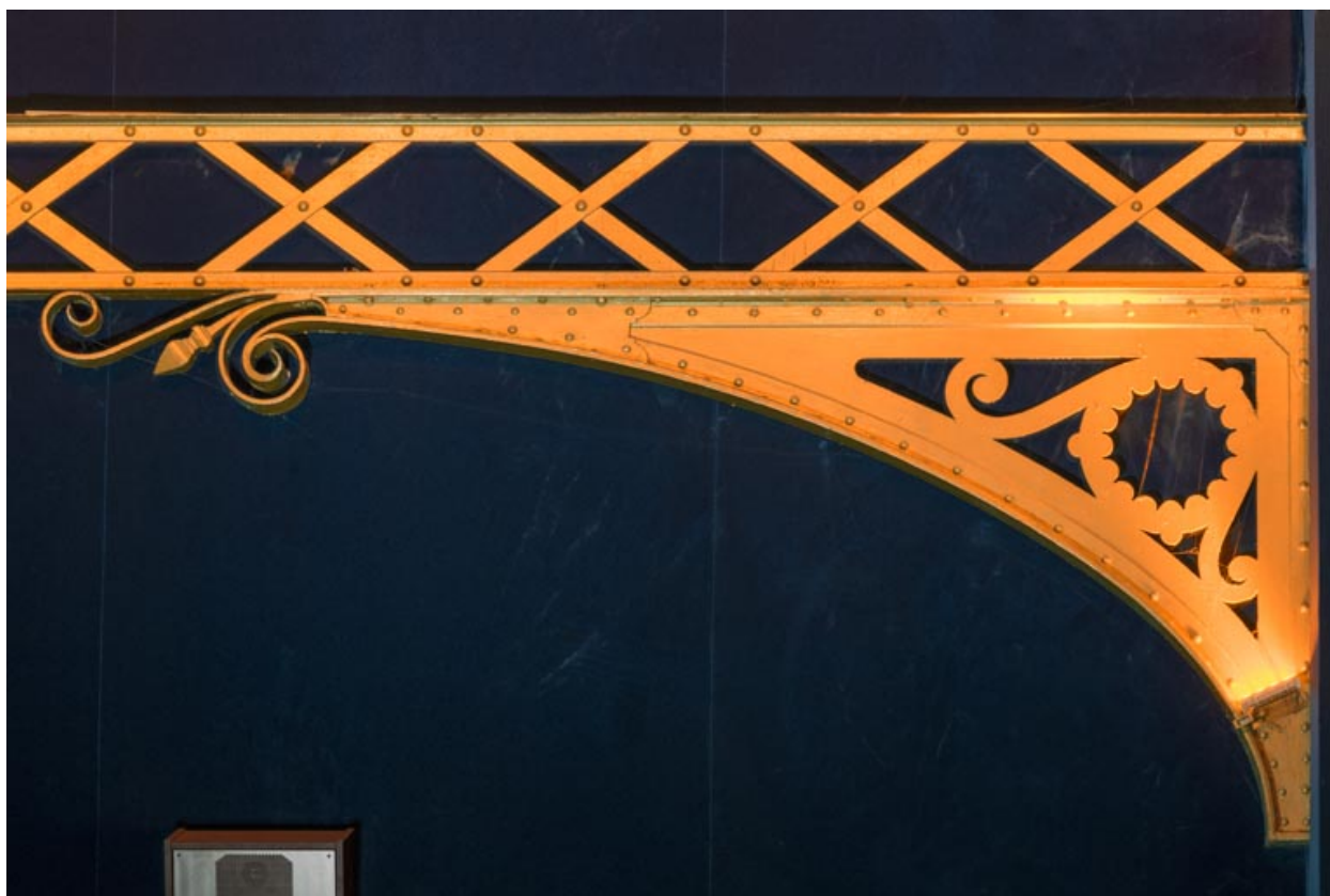
Cinéma, grande salle : détail de la charpente métallique (console).
