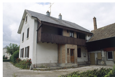
Façade sur cour du logement. Phot. Yves Sancey IVR43_20009000360ZA
