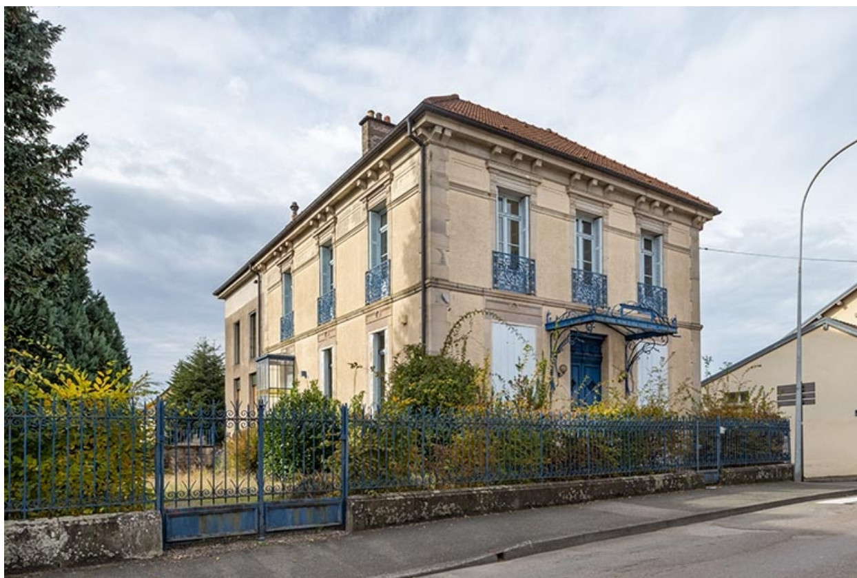
Vue d'ensemble depuis le sud-est (vue actuelle).
