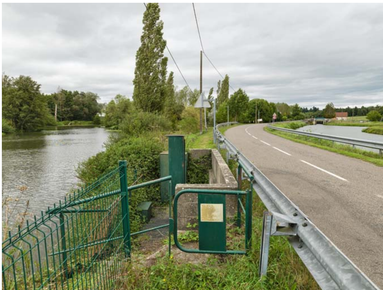
Vue de l'aqueduc.
