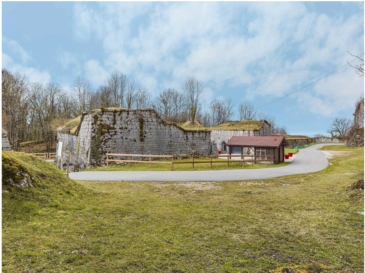
Vue depuis la base du demi-bastion est.
