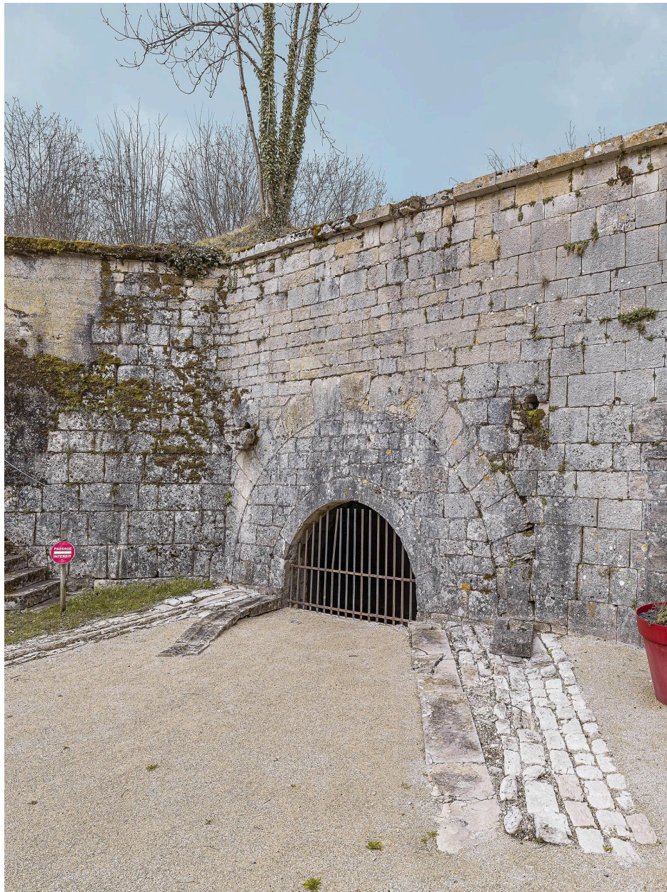
Casemate "époque Vauban".
