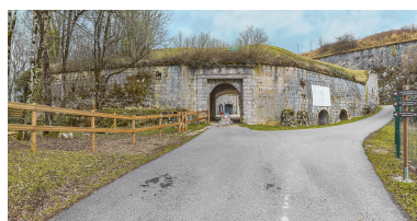
La demi-lune positionnée à l'entrée du fort. Phot. Thierry Kuntz IVR43_20223900469NUC4A
