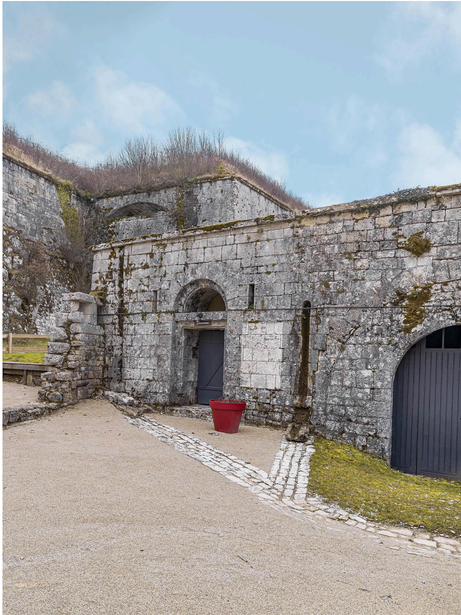
Entrées des casemates du flanc gauche.
