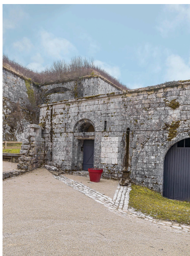
Entrées des casemates du flank gauche. Phot. Thierry Kuntz IVR43_20223900482NUC4A
