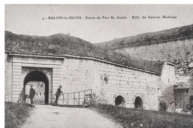
Salins-les-Bains. Entrée du fort Saint-André. S.d. Phot. Aline Thomas, Autr. auteur inconnu IVR43_20213900135NUC4A
