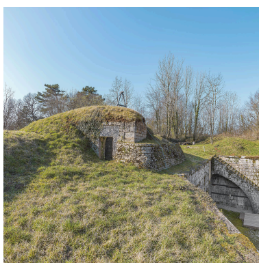
La casemate située sur le toit. Phot. Thierry Kuntz IVR43_20223900495NUC4A
