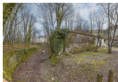
Vue générale. Phot. Thierry Kuntz IVR43_20223900499NUC4A
