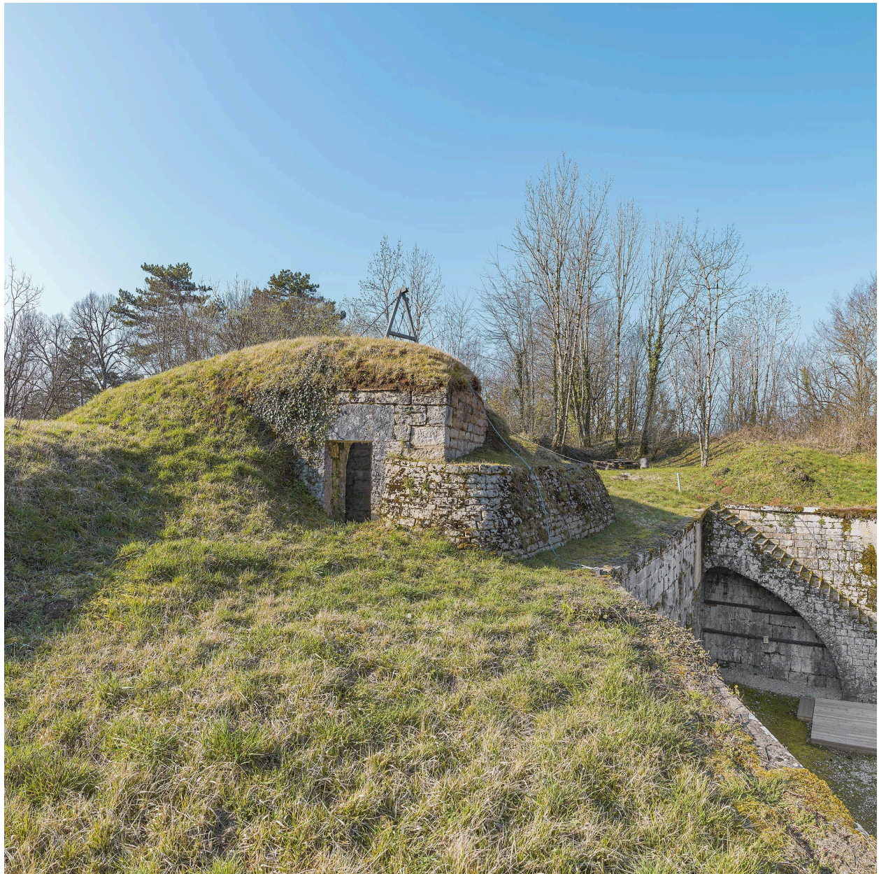
La casemate située sur le toit.
