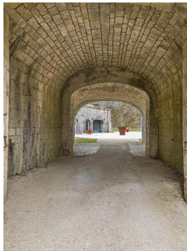
Le passage voûté. Phot. Thierry Kuntz IVR43_20223900477NUC4A
