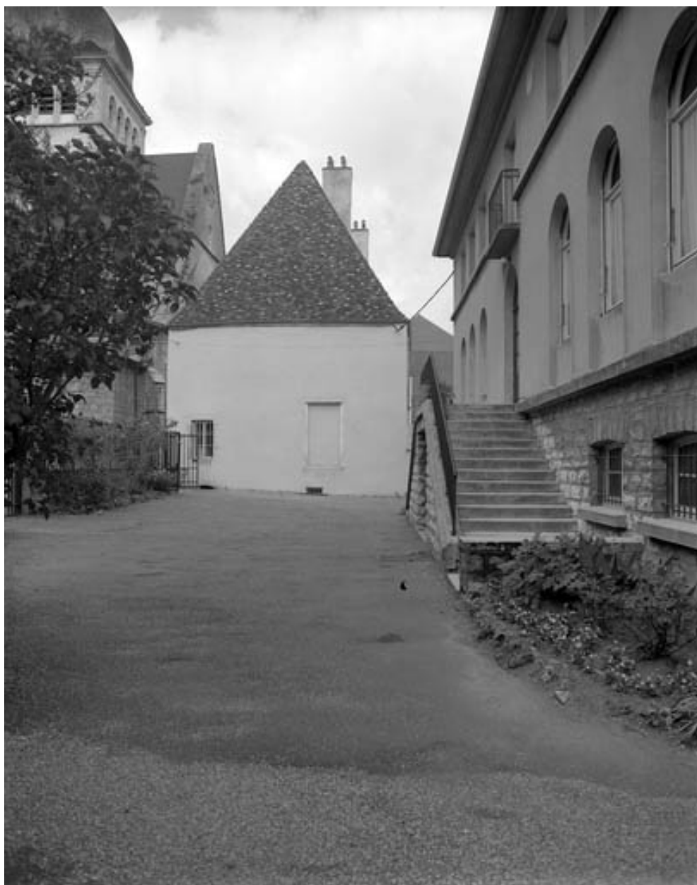
Façade latérale droite.
