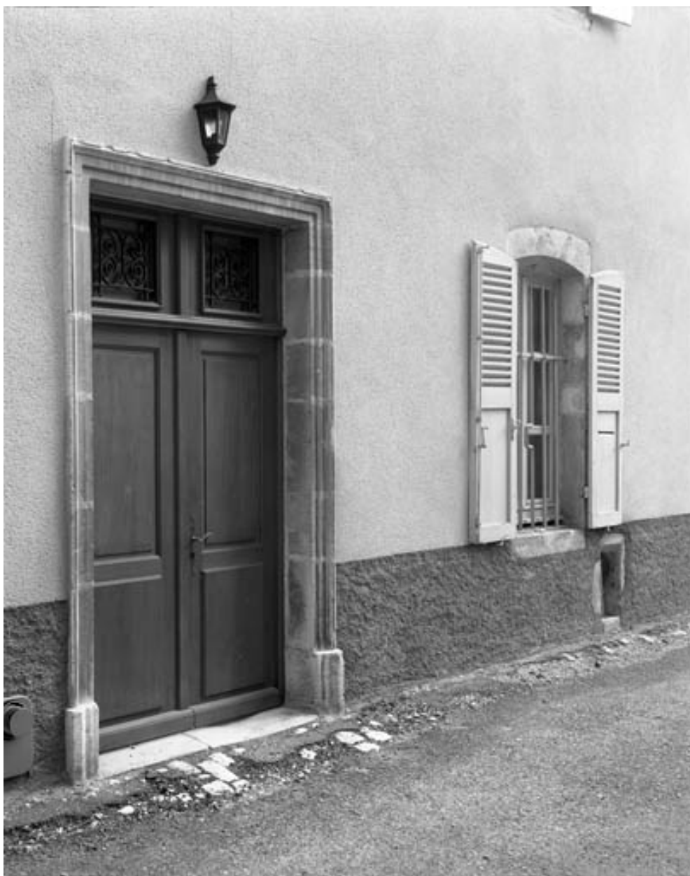
Portail d'entrée de trois quarts gauche.
