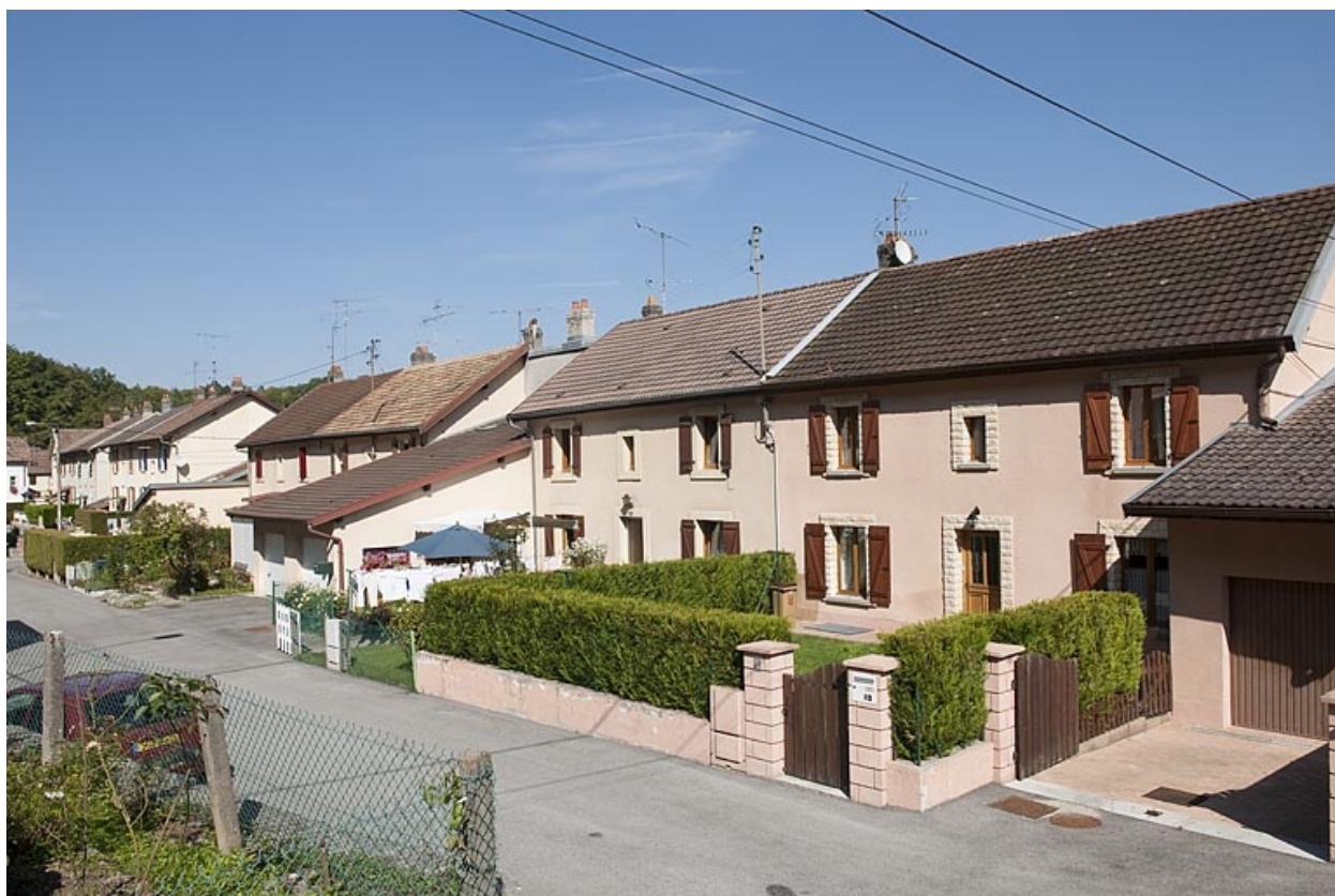
Vue d'ensemble rue de la Promenade.
