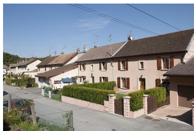
Vue d'ensemble rue de la Promenade. Phot. Jérôme Mongreville IVR43_20112502420NUC4A
