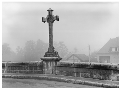
Détail de la croix monumentale sur le pont. Phot. non renseigné IVR26_19755800875V
