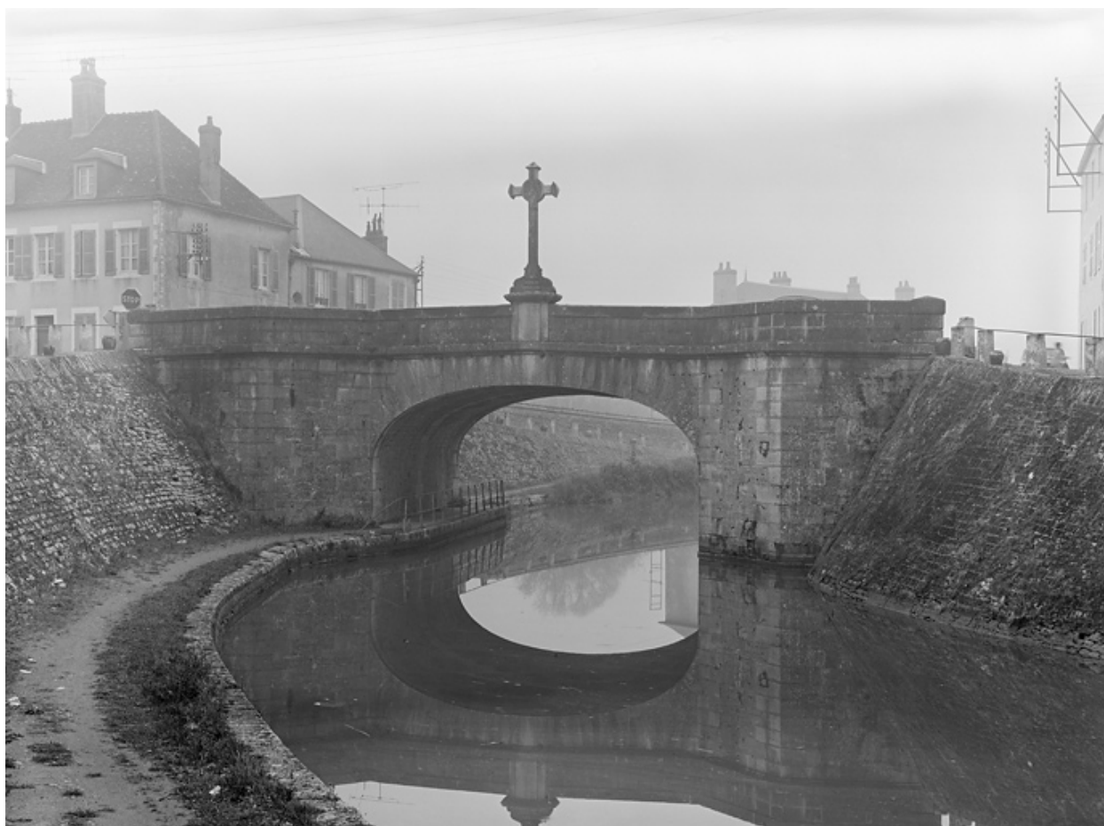
Vue d'ensemble depuis le chemin de halage.
