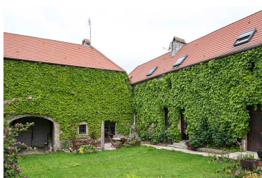
Les façades postérieures. Phot. Sonia Dourlot IVR43_20167000646NUC4A
