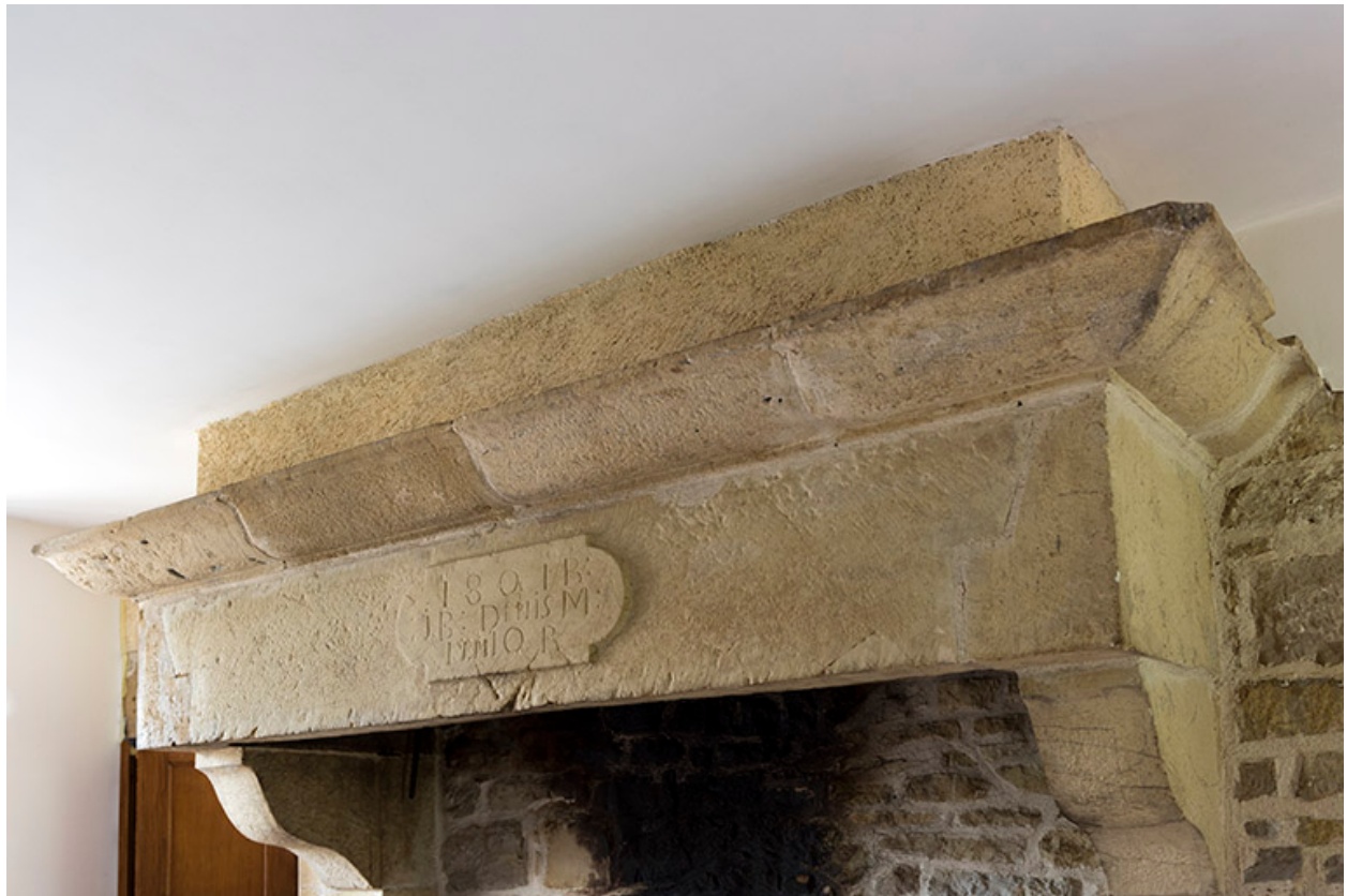
Cheminée dans la ferme côté rue.
