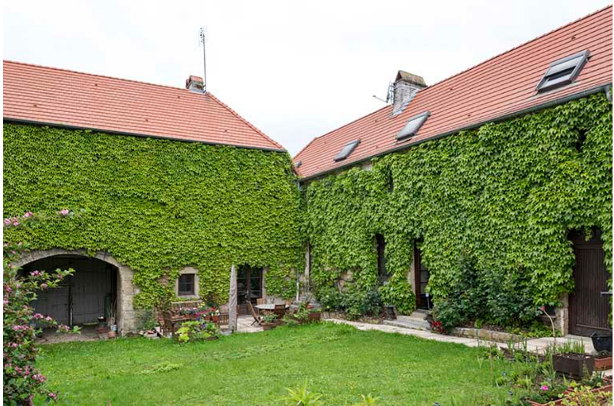
Les façades postérieures.
