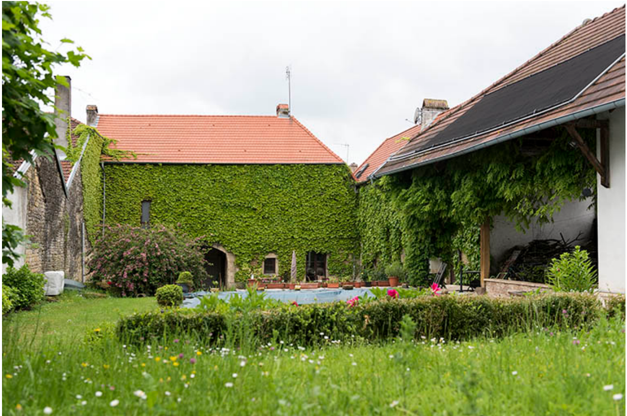
Vue générale de la cour intérieure.
