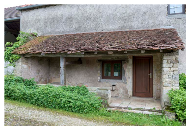
Auvent protégeant l'entrée. Phot. Sonia Dourlot IVR43_20167000641NUC4A
